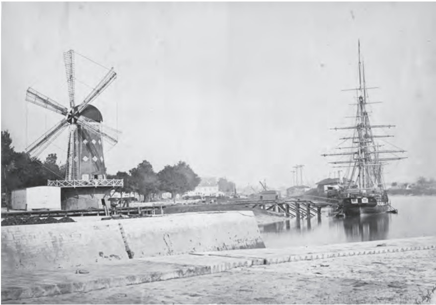
Fig. 3. – Photographie du moulin en novembre 1866
