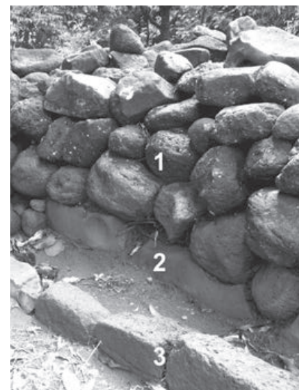
► Fig. 3 ◀ Détail du bord ouest de la structure PER-1, après décapage : premier parement marqué par un appareil irrégulier (1), assise du premier parement (2), assise conservée du deuxième parement marqué par un appareil plat plus régulier (3).
