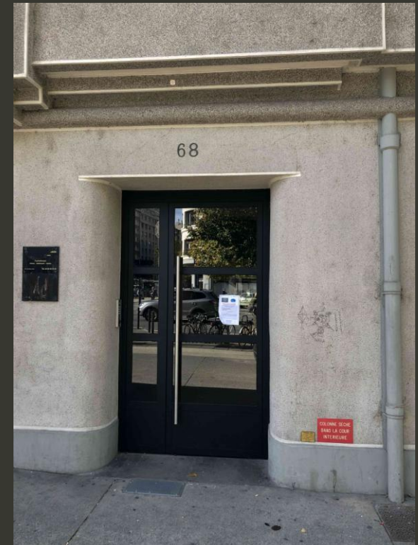
Porte Alu, Rénovation 2015
