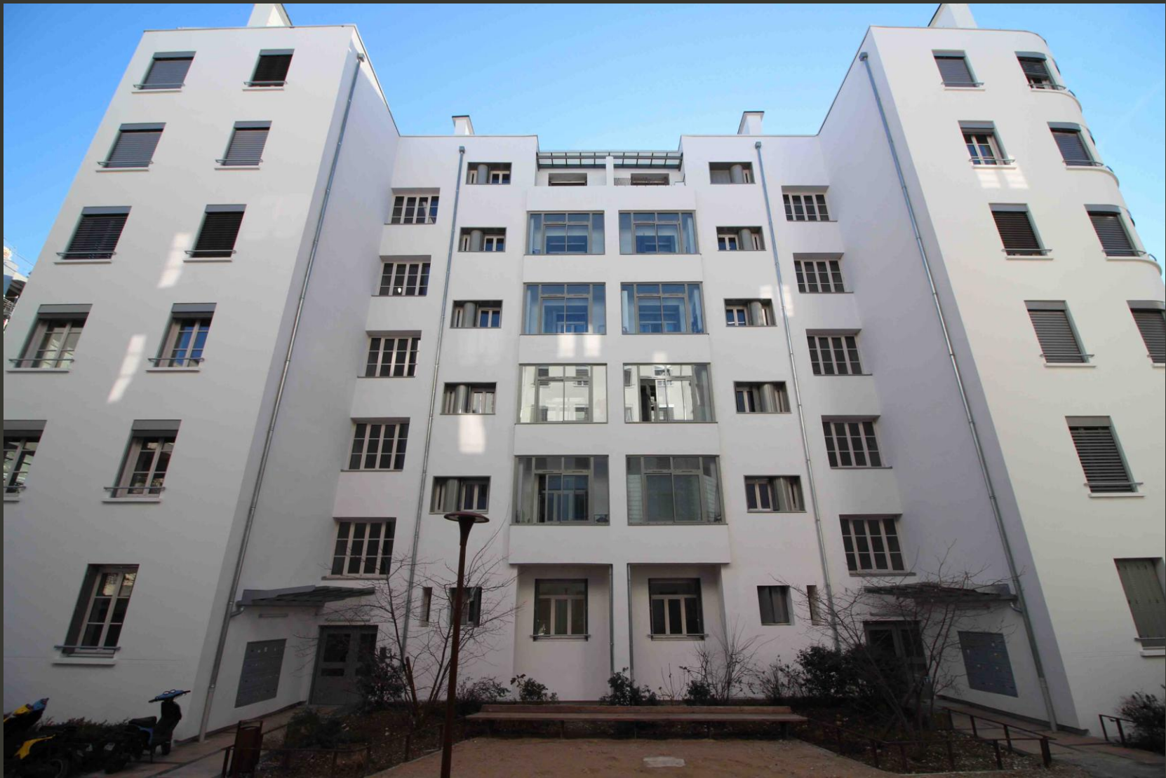
Perrache, Lyon, 1940, réhabilitation lourde, thermique, 2019.
