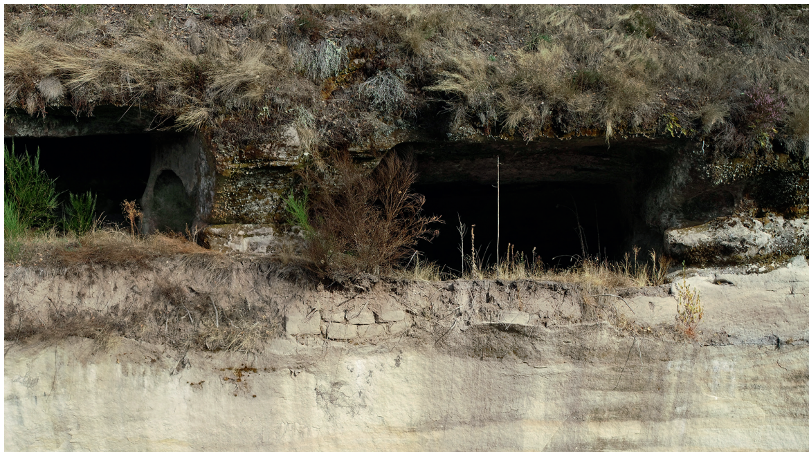
Fig. 18. Vue du site de Lamouroux, sous la cellule 32. Assises de pierres taillées de grès révélées par l'effondrement (Cellule drone, DRAC Nouvelle-Aquitaine).
