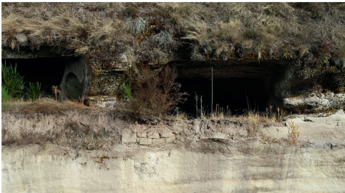
Fig. 18. Vue du site de Lamouroux, sous la cellule 32. Assises de pierres taillées de grès révélées par l'effondrement (Cellule drone, DRAC Nouvelle-Aquitaine).
