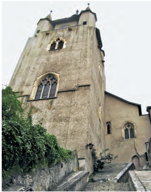
Fig. 16 Tour de l'église d'Orbe et ouvertures datant du 13 e siècle (© Archéologie cantonale, Lausanne, photo M. Liboutet).
