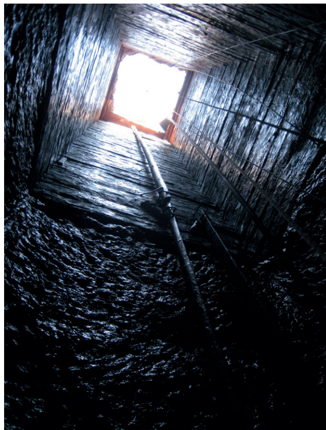
Fig. 1. Sainte-Croix VD, L'Auberson. Vue en contre-plongée du puits de mine. Boisage et vestiges d'une échelle avec fixation. L'ouverture du puits mesure 1.80 m de côté. Photo Archéologie cantonale VD, M. Liboutet.
