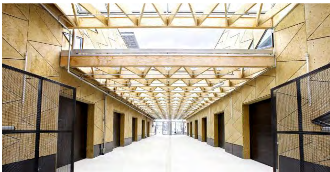
▲ Voirie dédiée aux ateliers de Greenbizz © Denia Zerouali
