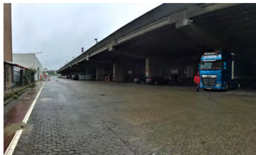
▲ Voirie réservée aux opérations du centre TIR, connectant les ateliers présents sur le TACT © Hugo d'Assenza-David
