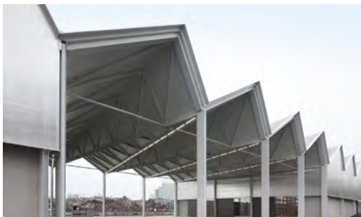
▲ Un entrepôt du village de la construction, dont la conception évoque des piliers ancrés dans l'eau © Cordeel
