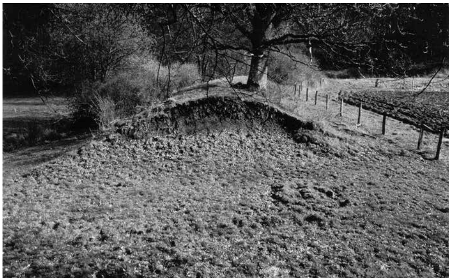
Fig. 8. La chaussée en terre de l'étang de l'Huilerie. (Benoît Rouzeau, 2006)
