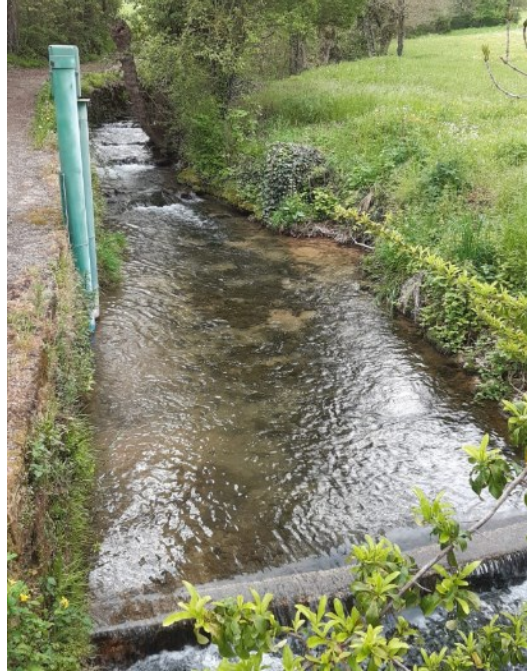
Figure 1 : Station hydrométrique du Ru de l'Homède à Creissels (Crédit photo Christophe Apolit PNR des Grands Causses)
