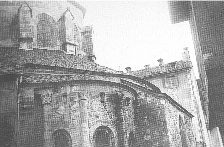
Figure 12. — Absidiole sud de Saint-Martin de La Canourgue.
