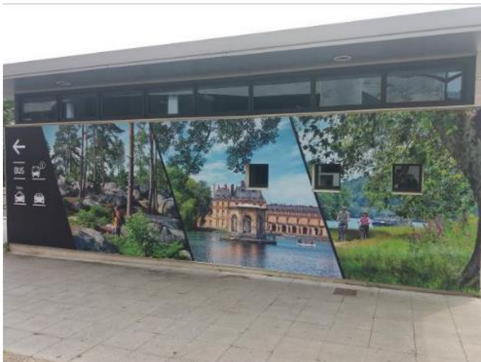
Figure 5 : Pelliculage du bâtiment d'information gare routière et information tourisme (Source : Faugier, 2020)
