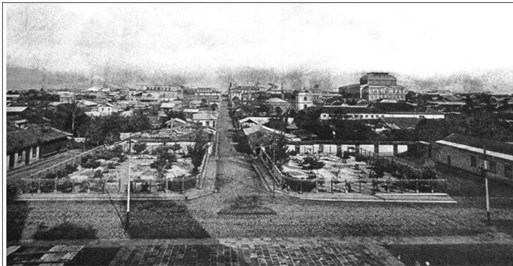
Figura 4 - Crescimento horizontal no centro de San José, nos inícios do século XX Fonte: Gómez & Zamora (2008).
