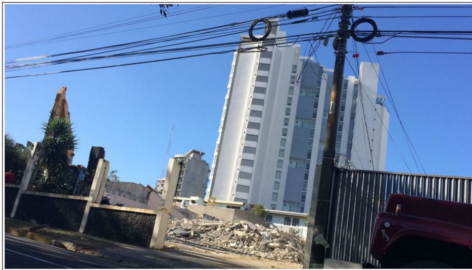
Figura 14 - Casa demolida para abrir espaço para futuros projetos residenciais verticais no bairro de alto padrão Rohrmoser Fonte: Acervo do autor (2016).
