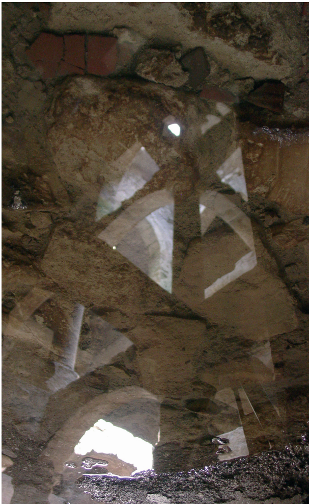
▼ 8. Jeu du reflet dans l'eau de l'élévation de la structure interne de la citerne el-Nabih composée de points d'appuis et d'arcs entrecroisés, étagés sur trois niveaux.
