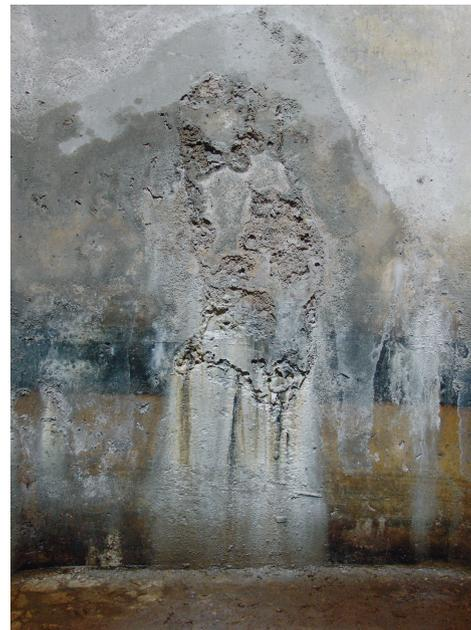
◀ 4. Infiltrations et concrétions salines sur les parois de la cuve
