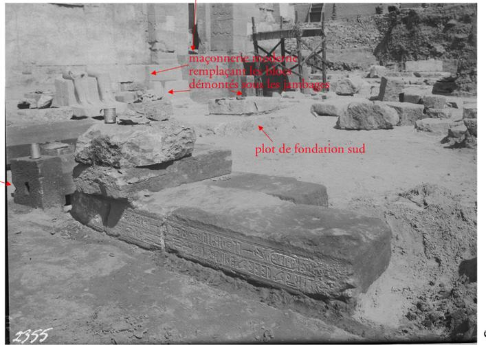
maçonnerie massive remplaçant les blocs démontés sous les jambages
