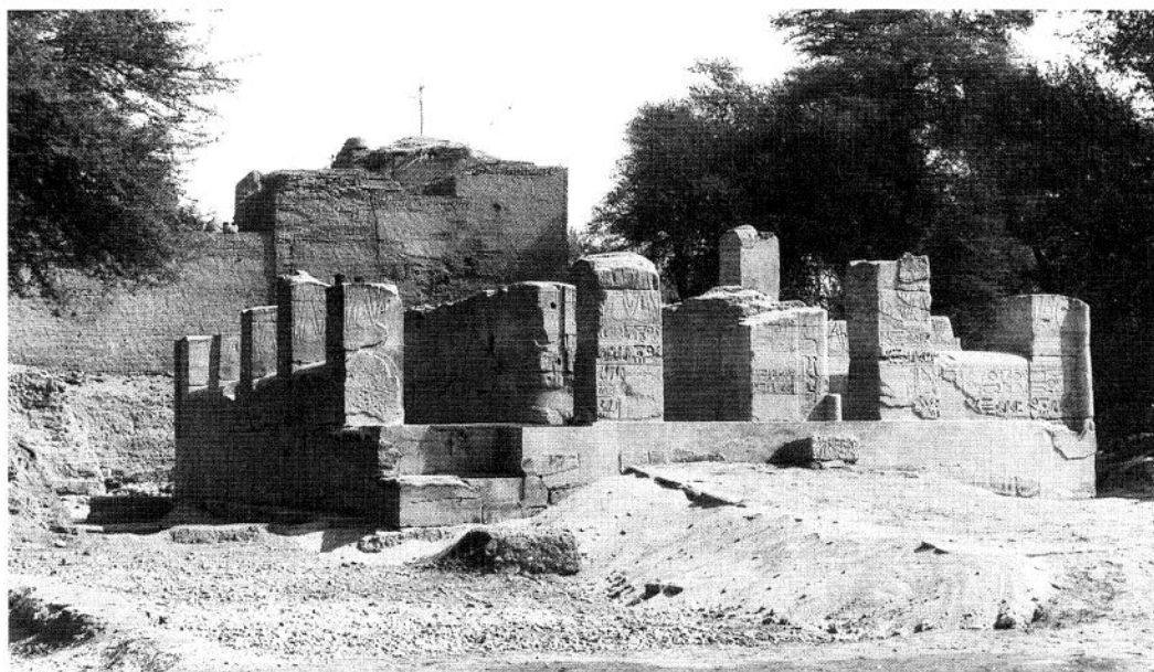
Fig. 4. — Vue générale de la chapelle depuis le sud-ouest.
