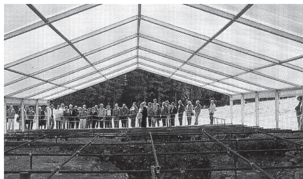
Fig. 7. Fouille de Bibracte. Couverture des chantiers (photo Bibracte/A. Maillier).
