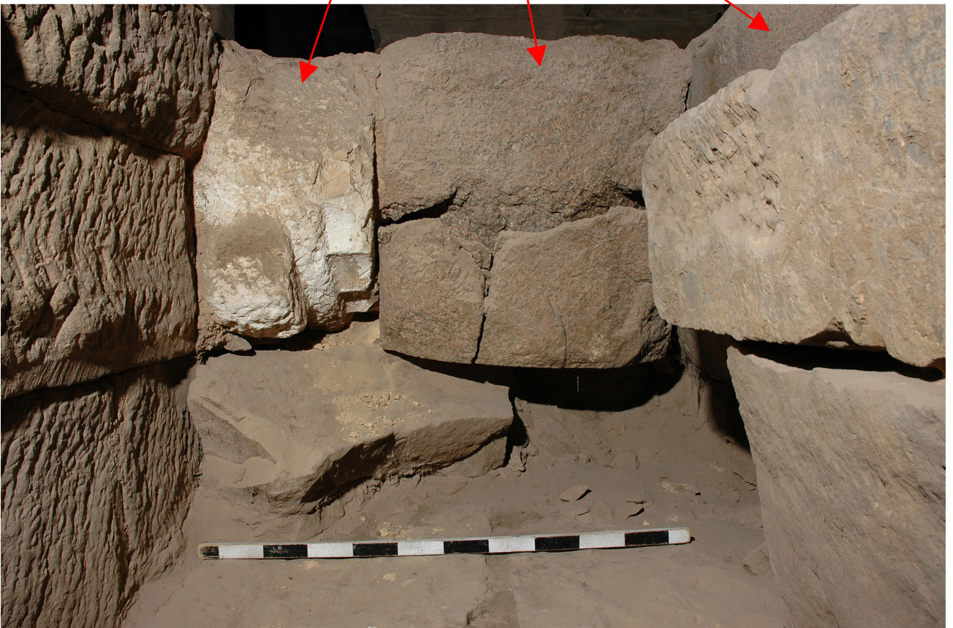
gros blocs en granite et en calcaire employés en dallage du radier du temple d'Opet
