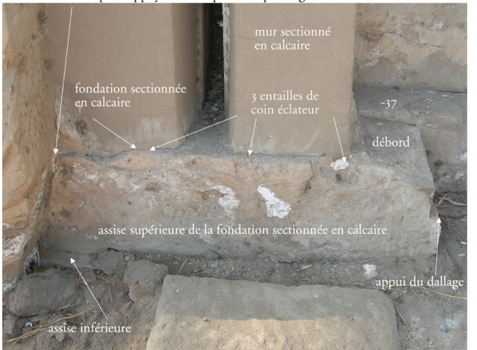
b débord sectionné pour appuyer le mur ptolémaïque en grès
