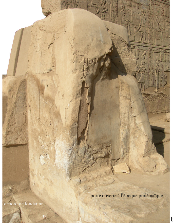
b débord sectionné pour appuyer le mur ptolémaïque en grès
