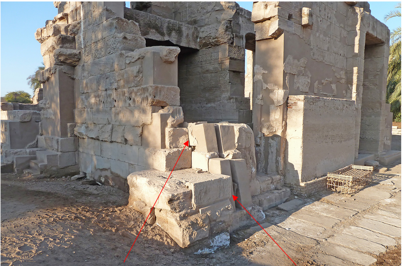
face de joint contre talutée du mur ptolémaïque adossé au parement taluté du mur prolongeant le refend de Sésostris I er et placé sur le côté sud du radier
