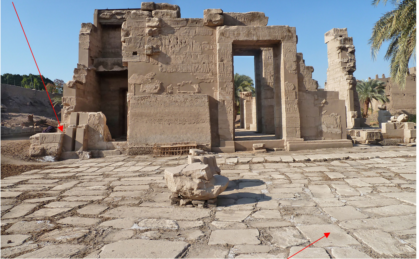
dallage reconstitué à l'aplomb du radier démantelé
