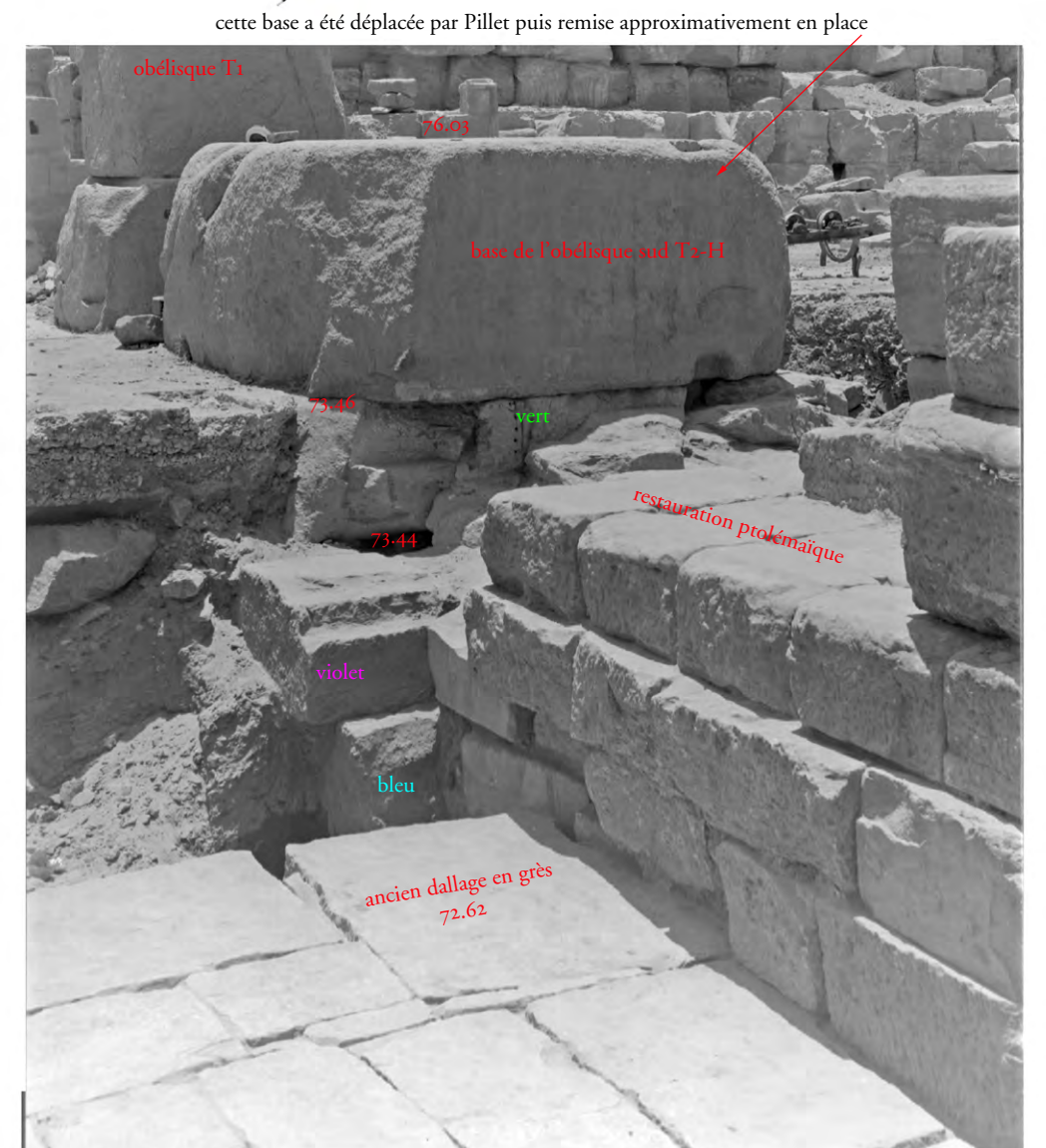
4. Fondation de l'obélisque adossé au môle sud du pylône III
