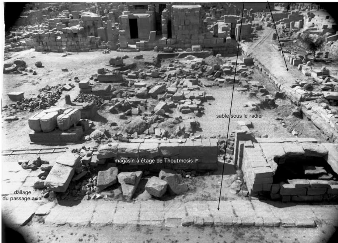
deux assises de fondation en grès vert des magasins nord et est du pourtour du radier, posées sur une épaisse couche de sable
