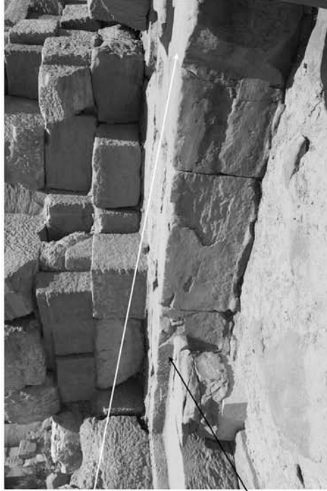
pièce latérale au sud du môle sud du IV e pylône
