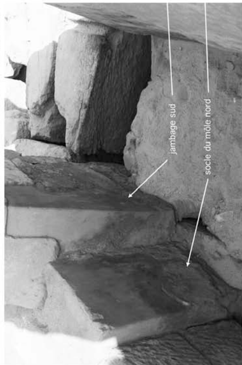
Bloc en grès commun à l'angle nord-ouest du socle du môle nord et à la première assise du jambage nord de la porte
