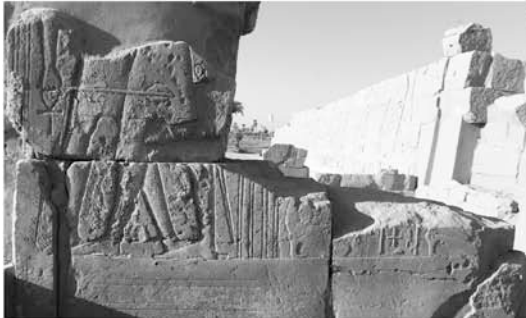
Face nord du pilier 1 d'angle sud-est : Roi →
