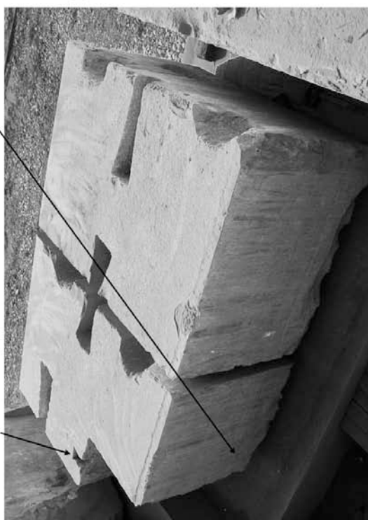
mortaise pour le crampon liant le mur d'ante à l'architrave perpendiculaire
