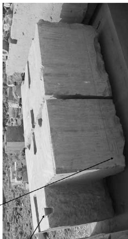
mortaise pour le crampon liant le mur d'ante à l'architrave perpendiculaire
