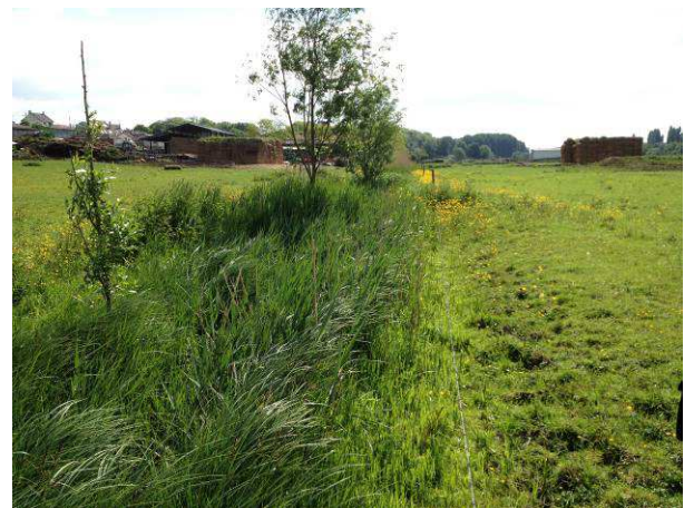
Drain humide à conserver et connecter avec le futur cours d'eau
