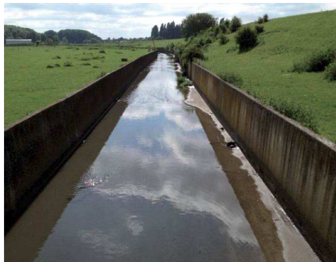
Le Petit Rosne à l'état existant
