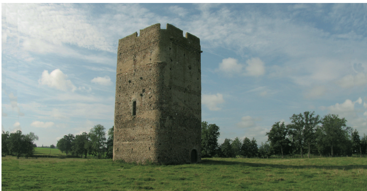
Fig. 11 : tour maîtresse de Lespinasse (cl. H. M. 2012)
