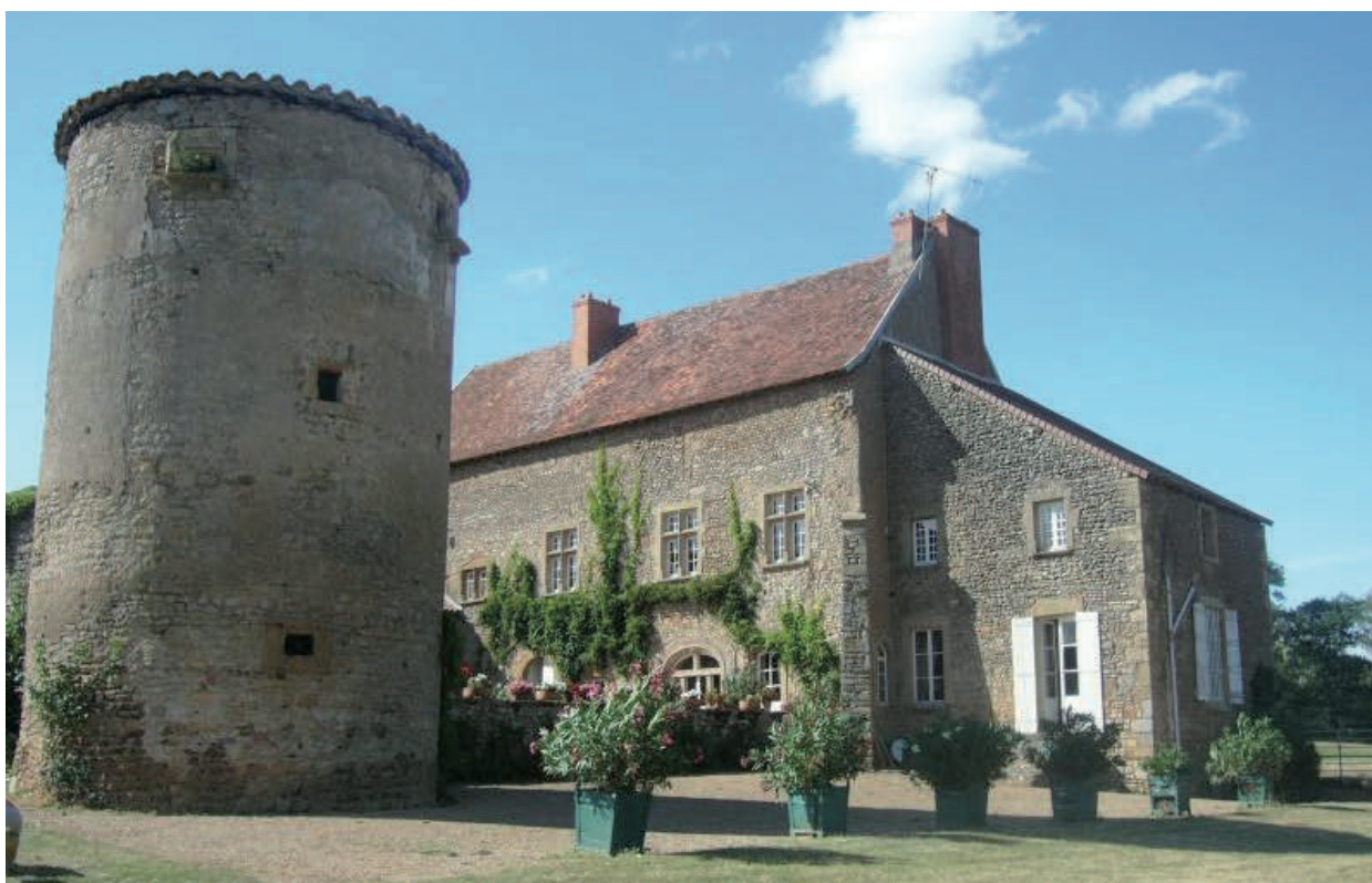
Fig. 18 : Sarry, état actuel des vestiges, vue du sud-est (cl. H. M. 2010)
