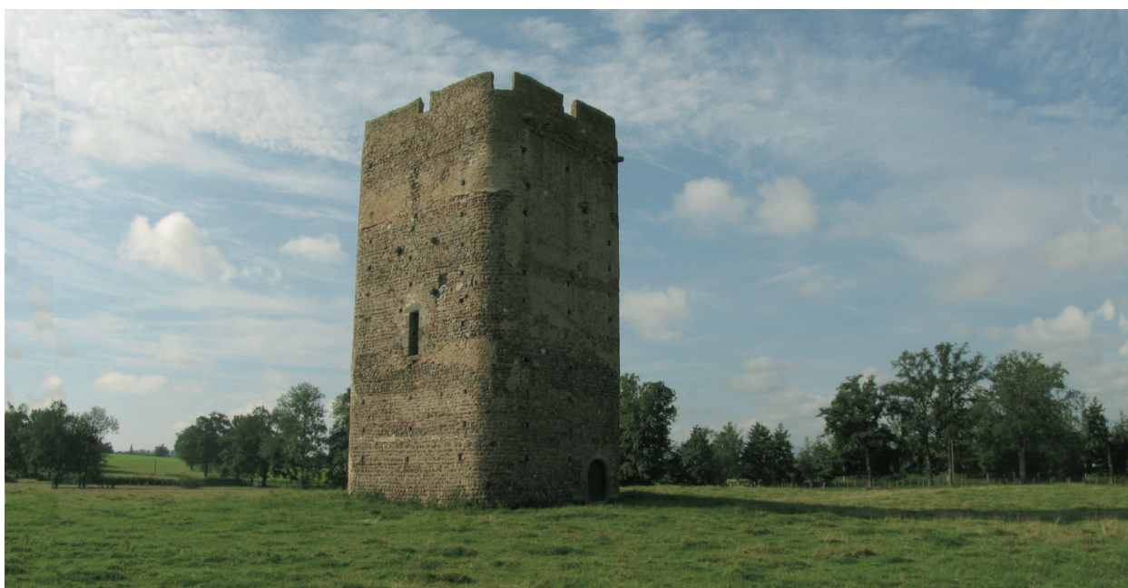
Fig. 11 : tour maîtresse de Lespinasse (cl. H. M. 2012)
