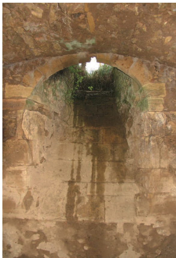
Fig. 15 : soupirail de la cave de la maison forte de Noyer (cl. H. M. 2012)
