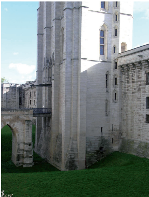
Fig. 6 : la tour du Village (entrée nord de l'enceinte). À la fin de 1995, les fossés ont été remis ici au niveau d'origine, 4,5 m sous l'actuel. Cette tour est la seule des neuf de l'enceinte qui n'a pas été arasée et qui a conservé sa hauteur d'origine. (Cl. J. Chapelot, ERCVBE, EHESS/CNRS).
