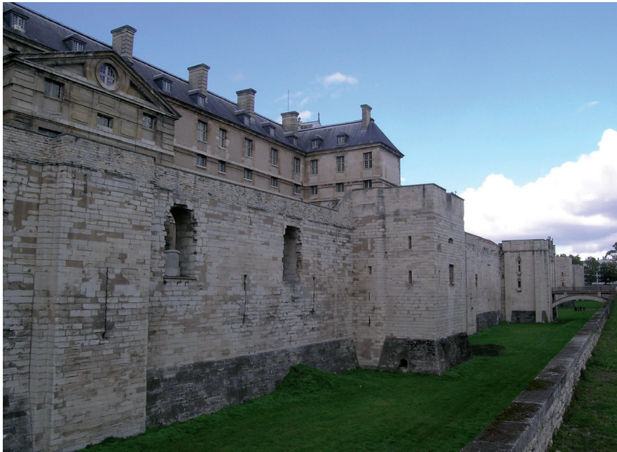
Fig. 5 : la courtine est du château. À gauche, l'avant-corps saillant au centre de la courtine qui sépare la tour de la Reine (à gauche et invisible sur ce cliché) et la tour de la Surintendance. À droite de cette dernière et successivement les tours des Salves, du Diable et du Réservoir à l'angle nord-est de l'enceinte. Le remblaiement des fossés sur 4,5 m de hauteur à la fin du XIX e siècle masque l'essentiel du fruit qui porte les courtines et les tours. (Cl. J. Chapelot, ERCVBE, EHESS/CNRS).
