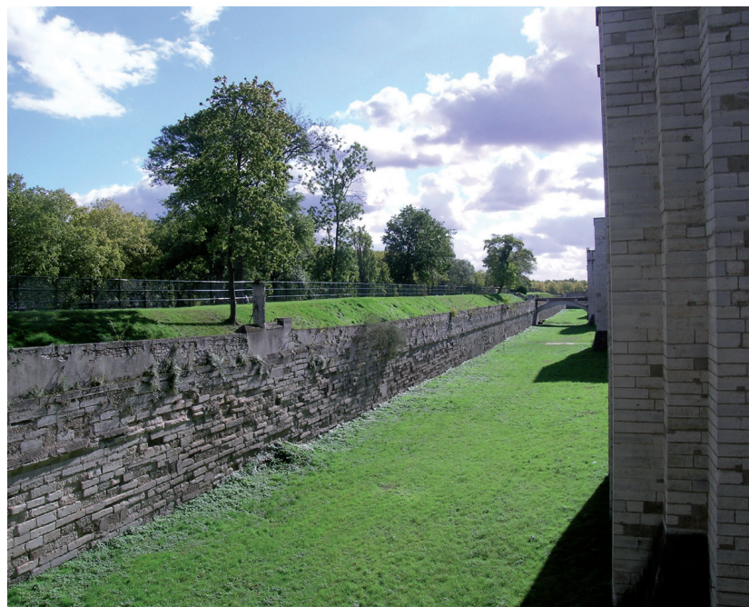
Fig. 7 : le mur de contrescarpe est. À droite, les contreforts de la tour du Réservoir qui constitue l'angle nord-est de l'enceinte du château. Comme partout ailleurs, ce mur de contrescarpe est en mauvais état, notamment déformé par la pression des terres. Le larmier ménagé vers son sommet est dégradé, mais visible. (Cl. J. Chapelot, ERCVBE, EHESS/CNRS).
