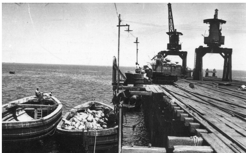
Figura 3. Muelle N° 2 con cuatro vías, dos centrales y dos laterales. Se ven también dos buzones y tres pescantes a vapor.
