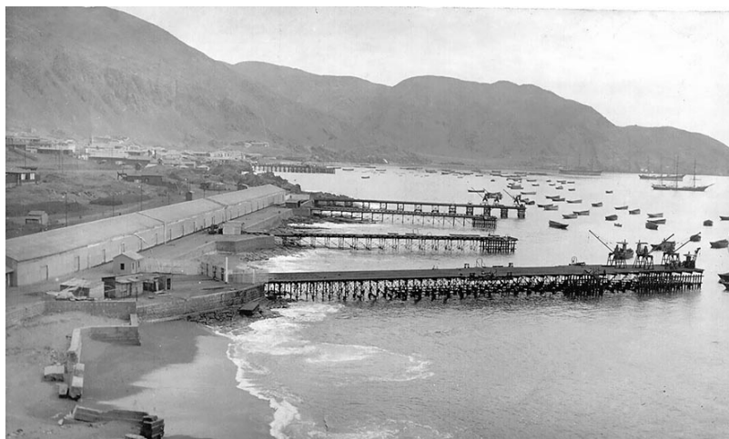
Figura 2. Recinto de la Compañía Ferrocarril Salitrero de Taltal. Muelles, bodegas, romanas y pescantes.
