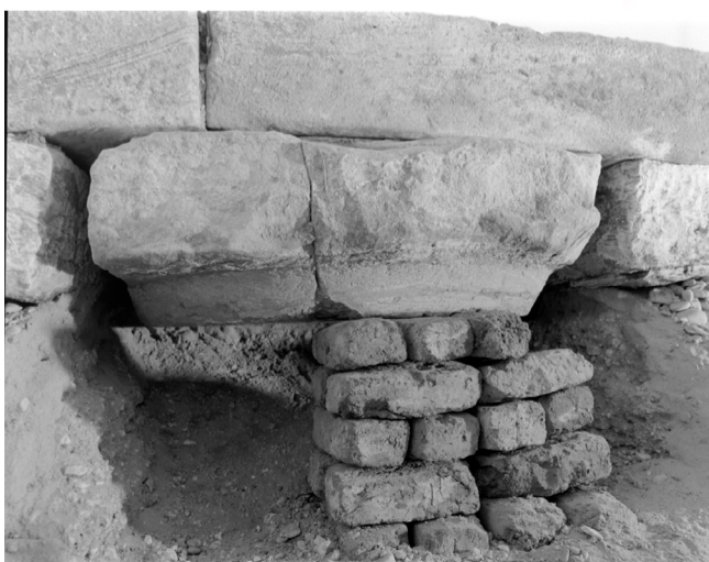
b. Une des deux bases de colonne en grès rouge remployées dans l'assise inférieure de la plate-forme (Gabolde-Carlotti, BSEG 23 , p 44, fig. 6 c et d)
