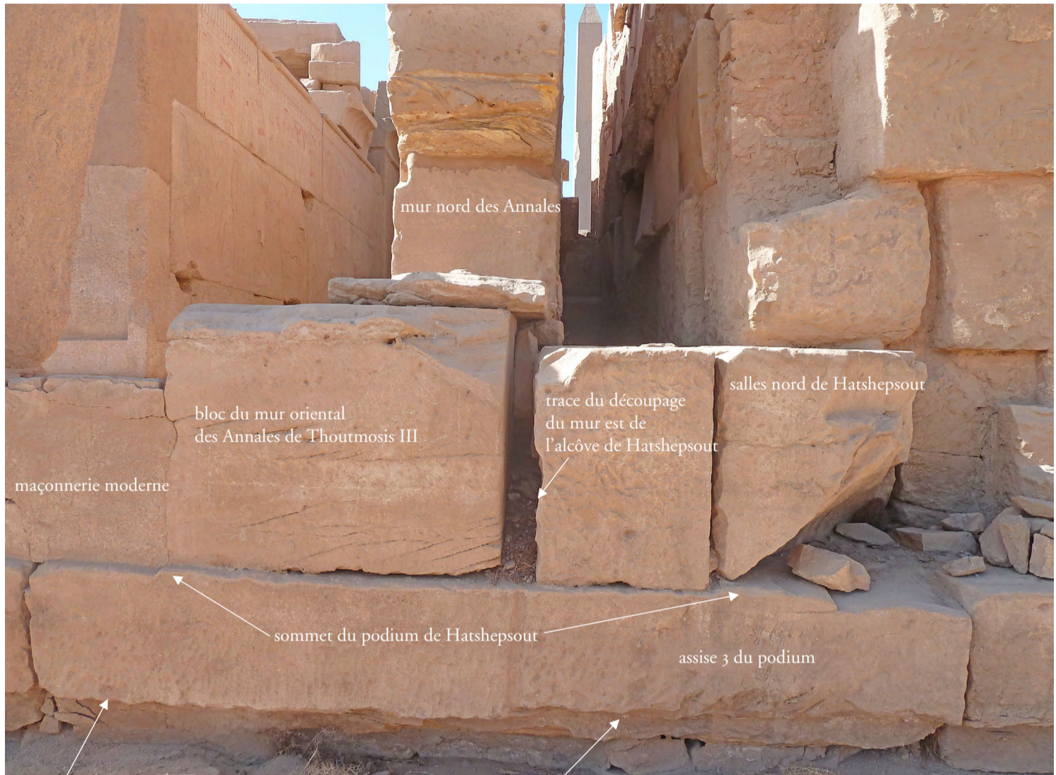
encastrement du podium de Hatshepsout sur l'arase ouest du radier calcaire
