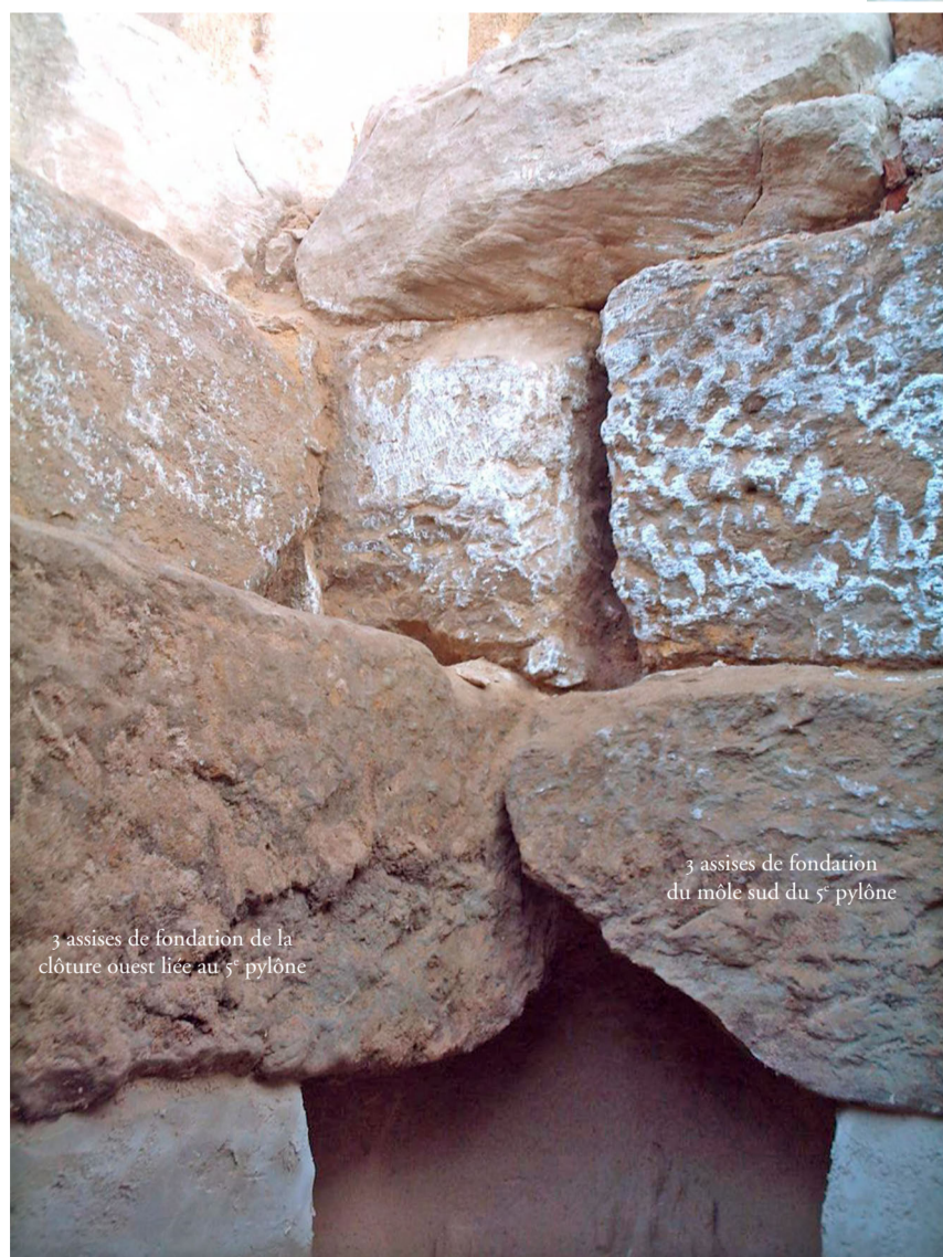
c. Angle nord-ouest des fondations de la pièce sud
