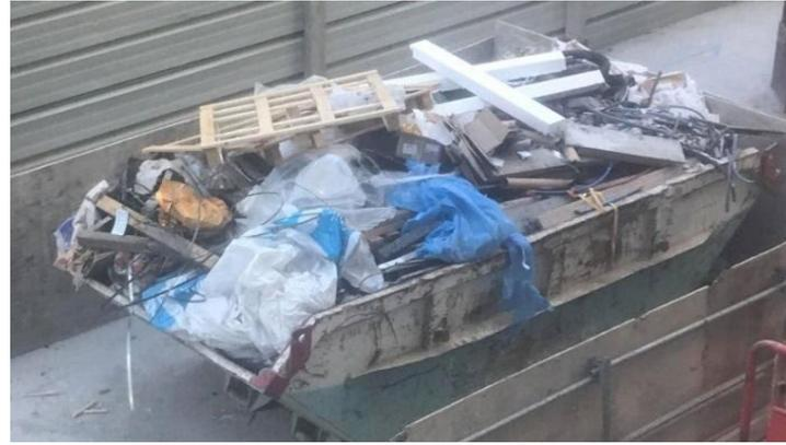
Figure 1 : Exemple de faibles pratiques de tri sur un site de construction (Copyright : Bauby, 2020)
