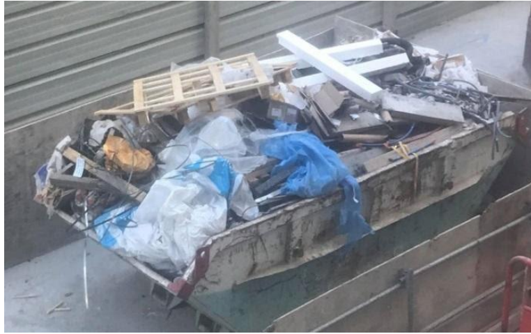
293 Figure 1 : Exemple de faibles pratiques de tri sur un site de construction (Copyright : Bauby, 2020)
