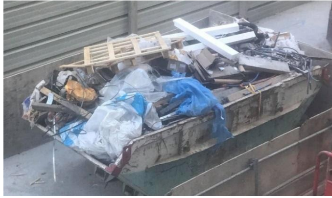
Figure 1: Exemple de faibles pratiques de tri sur un site de construction (Copyright : Bauby, 2020)
