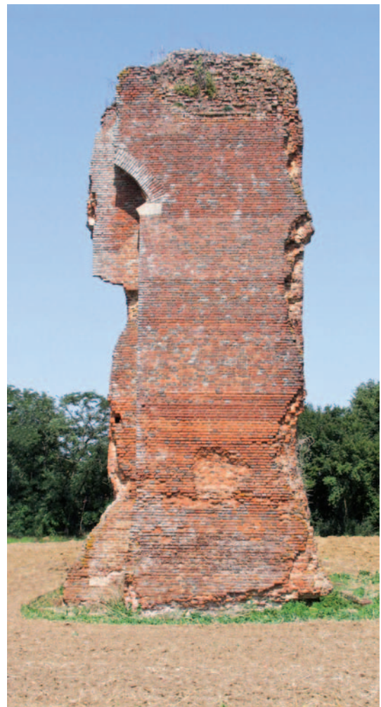
Vestiges du château d'Authumes : montant droit de la tour-porche. On distingue près du sommet le départ de l'arc de l'assommoir. Sur le mur du second plan, un arrêt de maçonnerie vertical est le vestige de la fente de flèche du pont-levis, qui s'ouvrait au second niveau de la tour.
