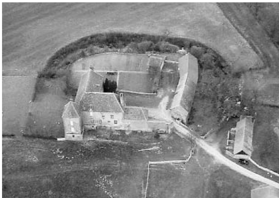
Maison forte du Monay. (Photo aérienne de M. Maerten)
