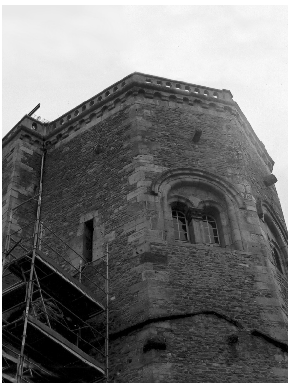
Fig. 14 : détail d'une des deux baies géminées et des parties sommitales, (photo C.B.)
