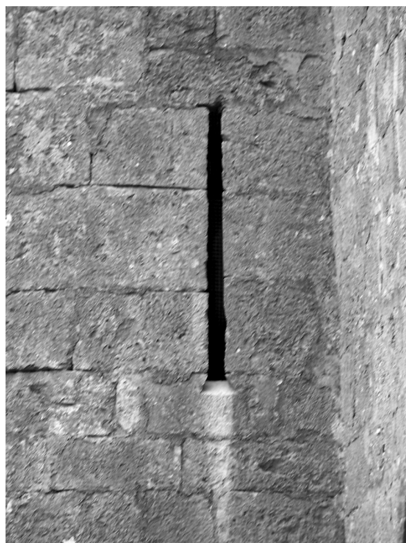
Fig. 39 : vue de l'archère à étrier de la tour d'escalier de l'église de Cussey-les-Forges (21).
