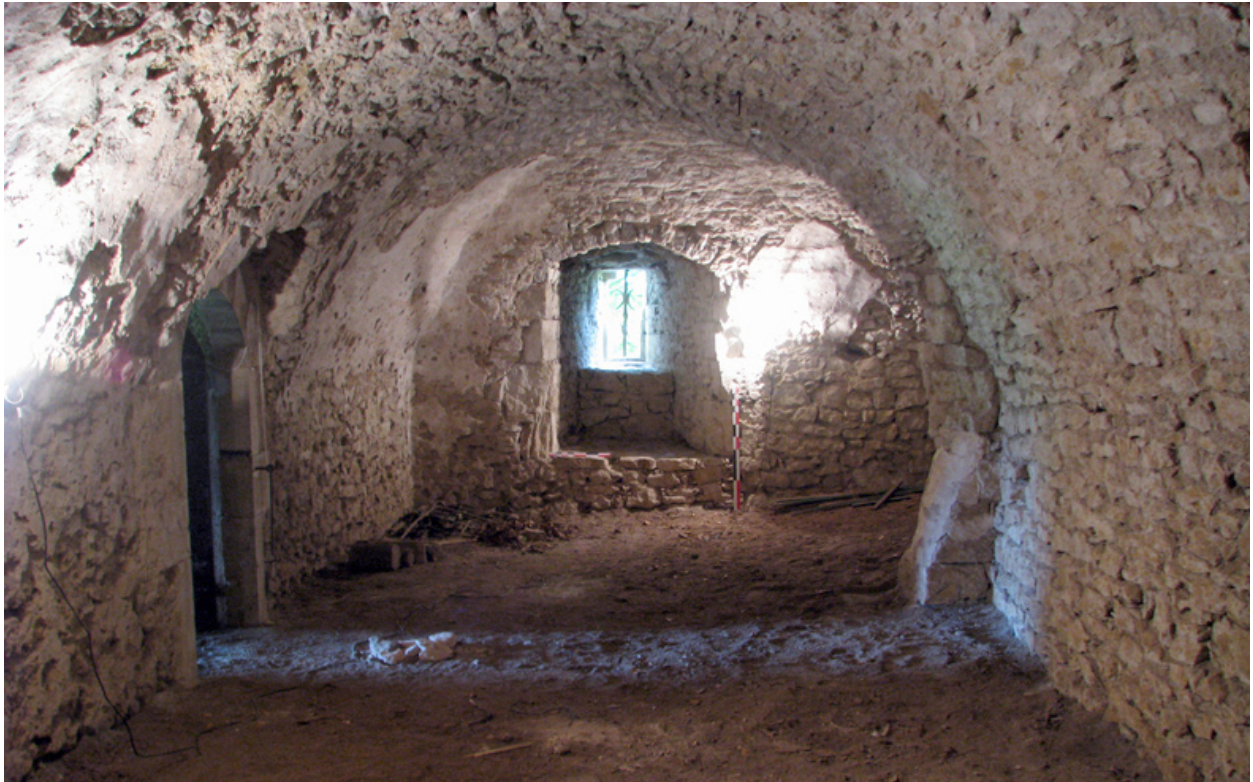
Fig. 16 : cave voûtée du bâtiment 1 vue de l'est (photo F.B.)
