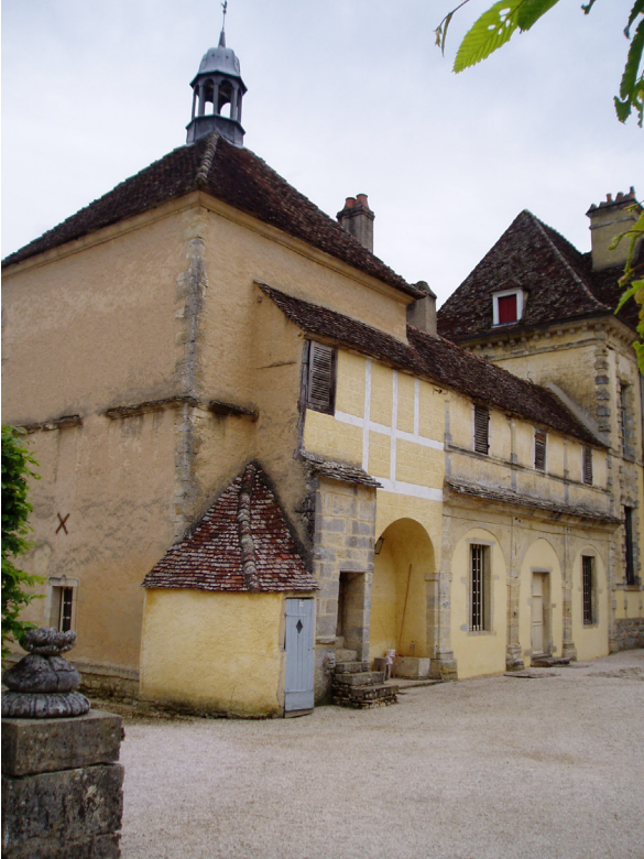
Fig. 13 : galerie orientale et pigeonnier. (Photo S.L.C., 2005).
