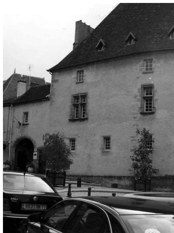
Fig. 9 : façade de l'ancien couvent des clarisses urbanistes, depuis la rue Baudinot (photo F.C.).
