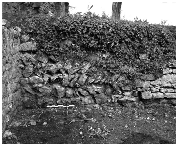
Fig. 8 : base du bâtiment 1 de la haute cour avec son appareillage en opus spicatum sur la face est (photo F.B.)
