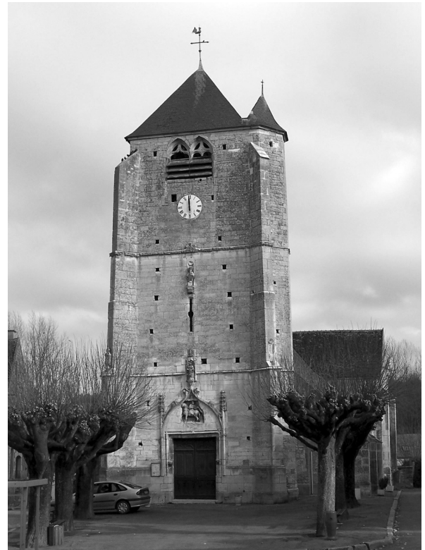
Fig. 5 : clocher de l'église de Chichée ; archère-canonnière en façade.
