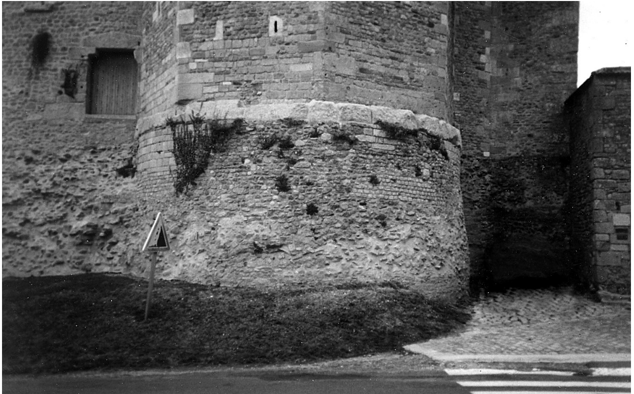
Fig. 6 : la base gallo-romaine vue de l'ouest (photo C.B.)
