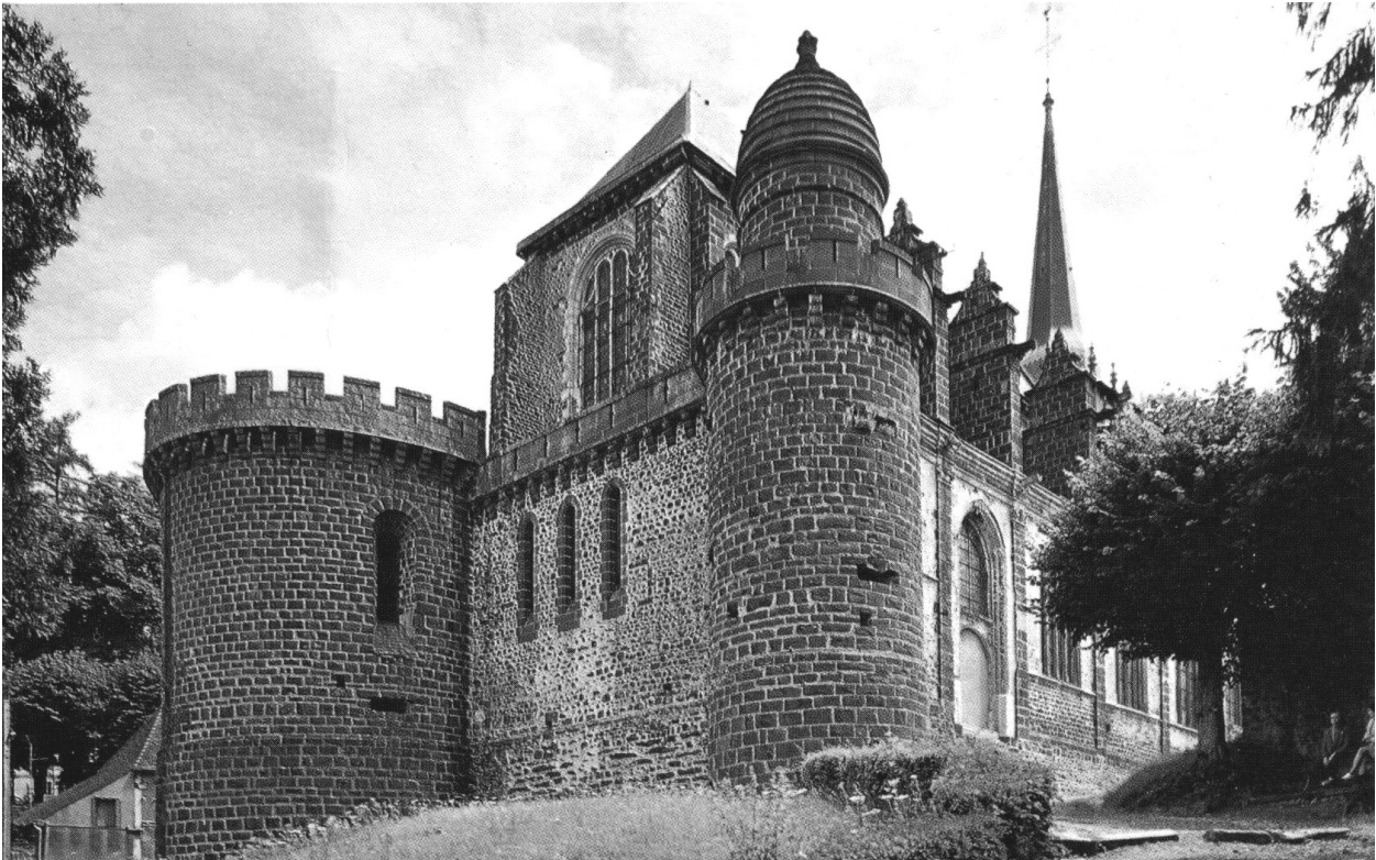
Fig. 42 : vue du chevet fortifié de l'église de Toucy (89).
