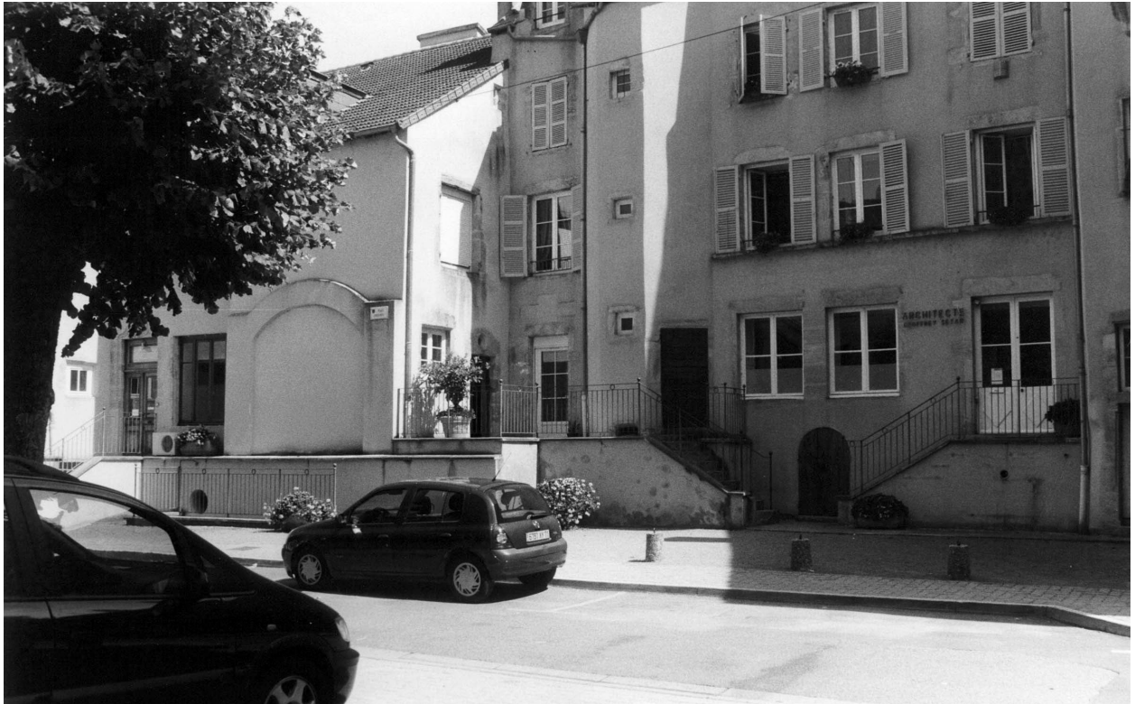
Fig. 18 : façades sur la rue Baudinot des maisons gothiques conservées aux n° 8 rue Baudinot et 9 rue Gambetta : on remarque la présence de la terrasse en rez-de-chaussée (photo F.C.)
