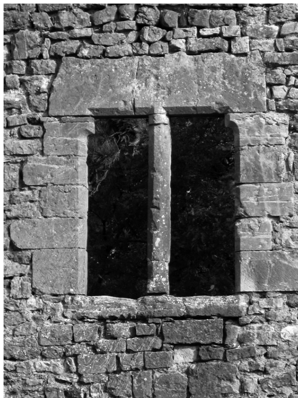
Fig. 18 : baie ouest du bâtiment 1 (photo F.B.)
