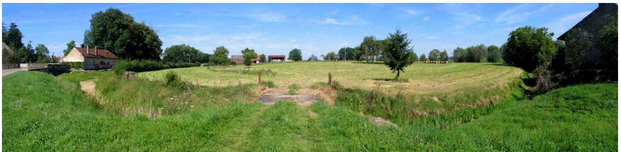
Fig. 16 : plate forme du château de Longepierre (photo H. Mouillebouche, 2007).
