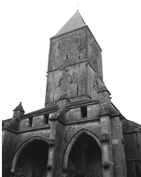
Fig. 21 : vue du clocher de l'église de Rougemont.
