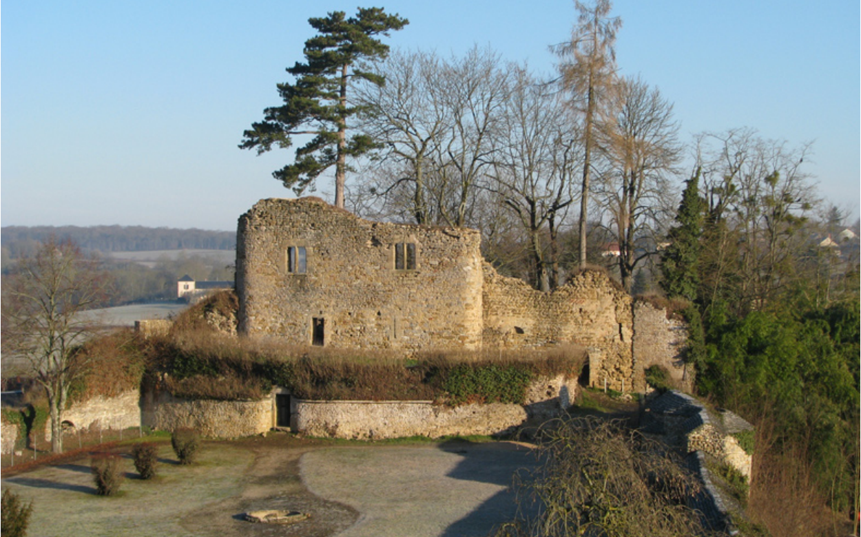
Fig. 2 : les bâtiments 1 (à gauche) et 2 (à droite) de la haute cour (photo F.B.)
