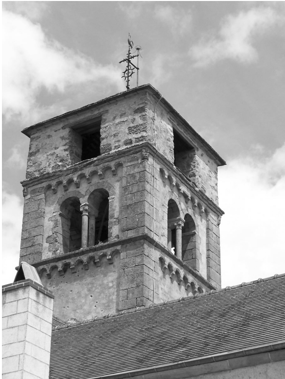
Fig. 26 : vue du clocher de l'église de Bergesserin.
