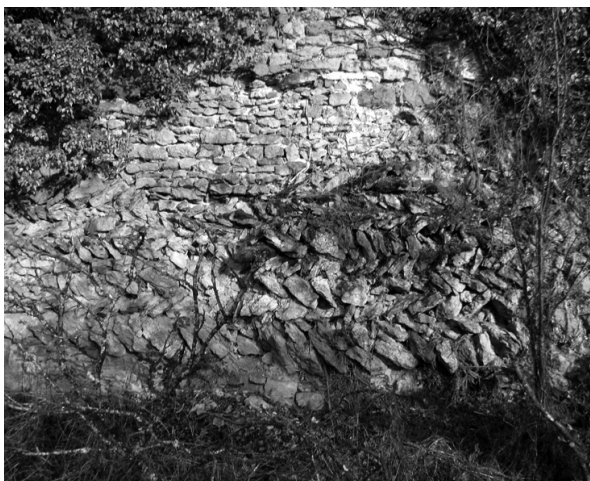
Fig. 7 : base du bâtiment 1 de la haute cour avec son appareillage en opus spicatum sur la face ouest (photo F.B.)
