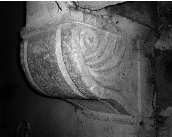
Fig. 7 : logement du fermier : corbeau de la cheminée. (Photo S.L.C., 2005).
