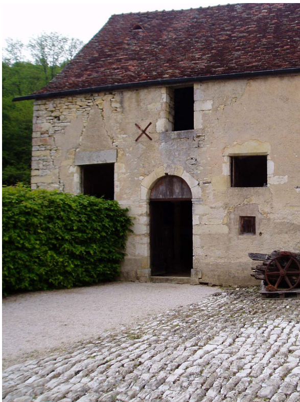
Fig. 9 : façade antérieure de l'écurie. (Photo SLC, 2005).
