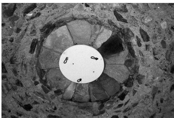
Fig. 11 : accès originel à la cave (photo C.B.)
