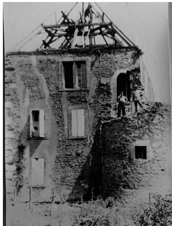
Fig. 37 : démolition du château de Barrat, après 1935. ( Archives de la Physiophile ).
