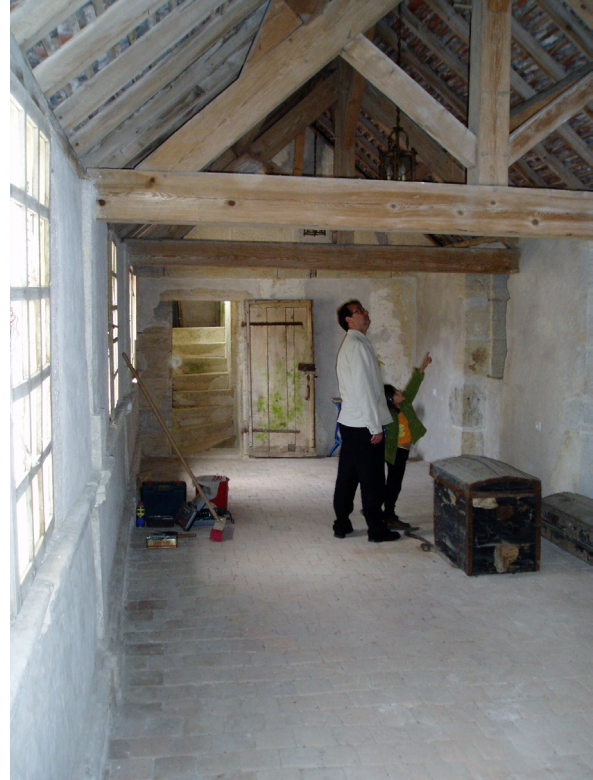
Fig. 14 : intérieur de la galerie occidentale. (Photo S.L.C., 2005).
