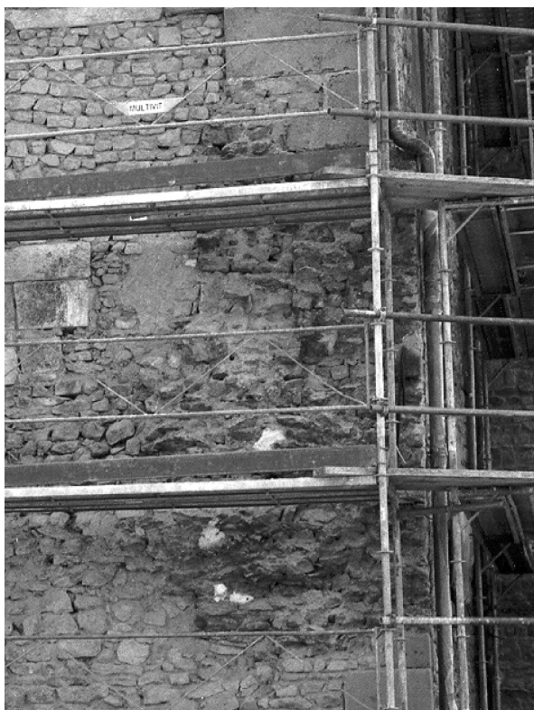
Fig. 18 : l'arrachement de la courtine sur la maison (photo C.B.)
