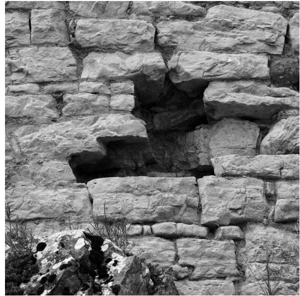
Fig. 4 : impact de boulet sur la face est de la tour ronde (photo N.K.)
