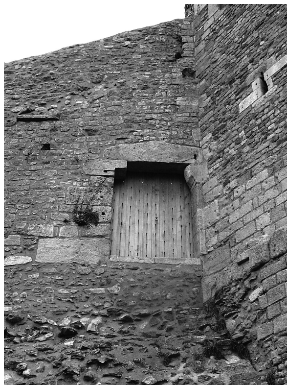
Fig. 19 : la poterne dans la courtine ouest vue de l'extérieur (photo C.B.)
