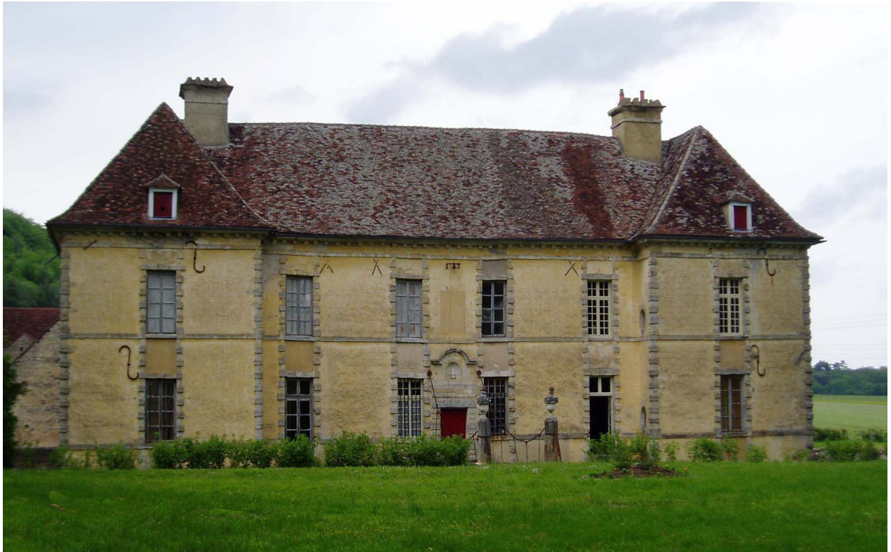
Fig. 8 : façade postérieure du logis. (Photo SLC, 2005).
