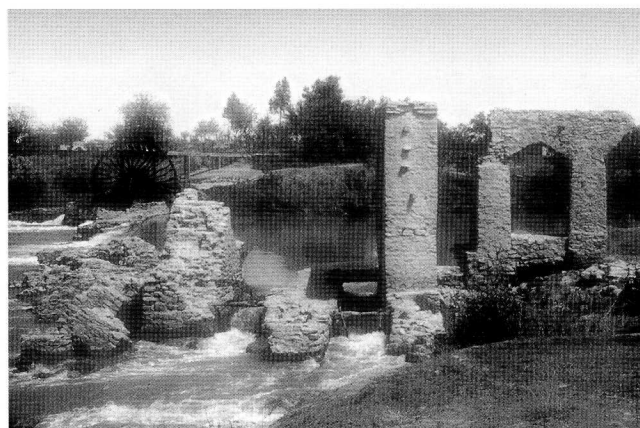
Photo 5. Vestiges d'une installation d'une „noria” sur le Khabour, près de sa confluence avec l'Euphrate.
