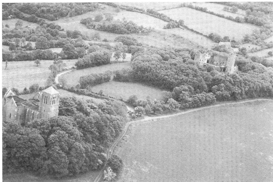
FIG. 2. — Collégiale et château de Thil-en-Auxois, vue du sud-ouest.
