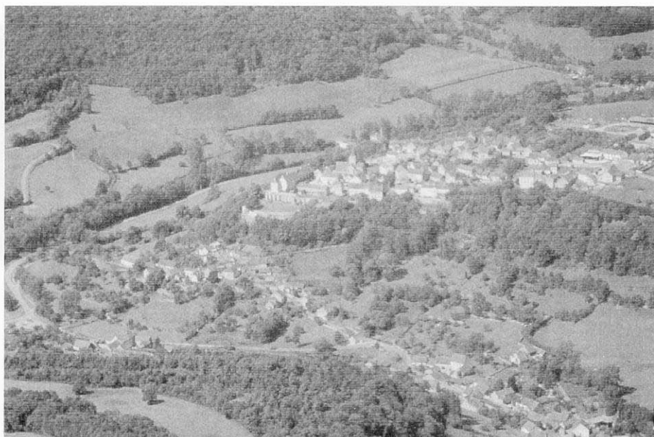
FIG. 6. — Frôlois, vue de l'est ; le château est à la pointe du plateau, à gauche de l'église.
