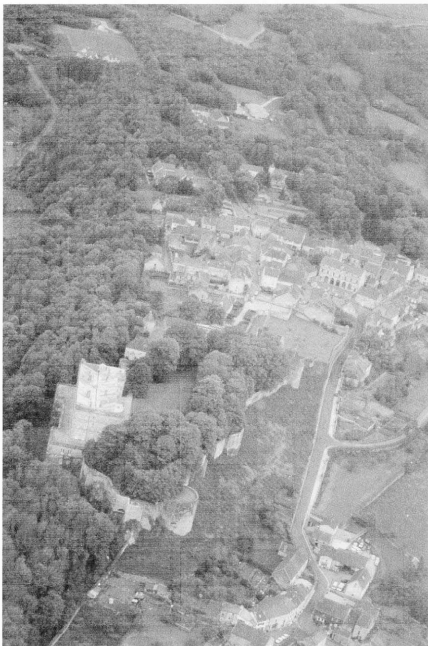
FIG. 5. — Château de Grancey, bourg supérieur et bourg inférieur, vue du sud-est.
