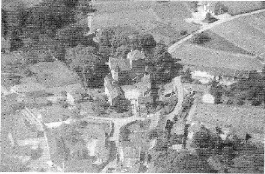
FIG. 1. — Maison forte de Gamay (Saint-Aubin) au milieu de son bourg : vue du nord-est.
