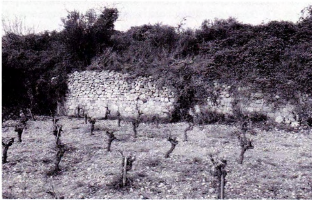
Fig. 4. – Les Moulières. Un mur de terrasse contemporain intègre une structure antique encore partiellement conservée (cliché : L. Schneider).
