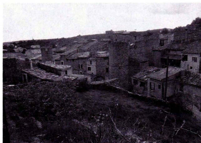
Fig. 10. – Vue générale des fortifications d'agglomération. (cliché : L. Schneider)
