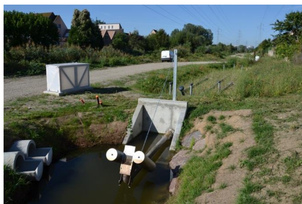
Figure 8. Ensemble de la filière de traitement des effluents provenant du bassin versant n°3 (le 7/09/12)
