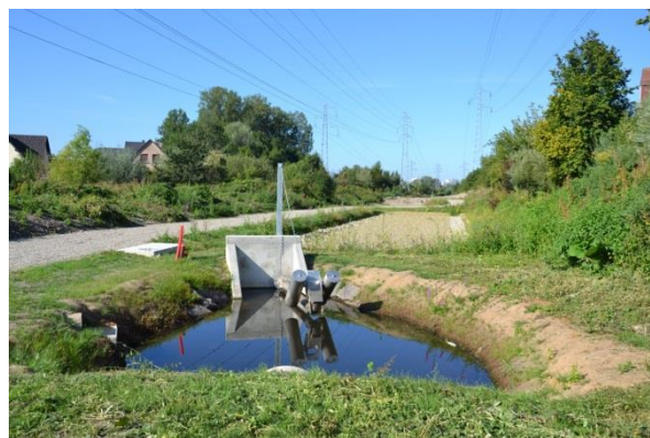
Figure 7. Ensemble de la filière de traitement des effluents provenant du bassin versant n°2 (le 7/09/12)
