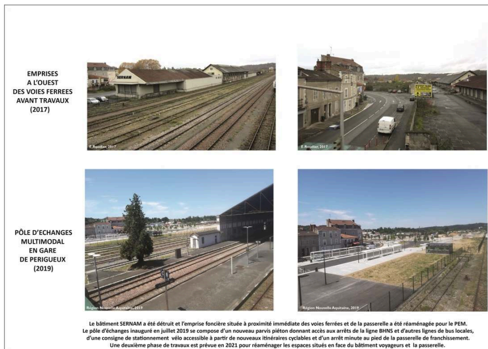
Figure 9. Le pôle d'échanges en gare de Périgueux : premiers aménagements à l'ouest des voies ferrées.
