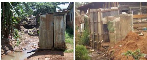
Figure 2 : Latrines à canon sans fosse (à gauche) et avec fosse de stockage (à droite)
