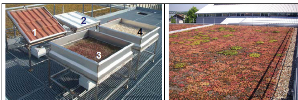
Figure 1 : Photos des panneaux et de la toiture suivis sur le site du CSTB
