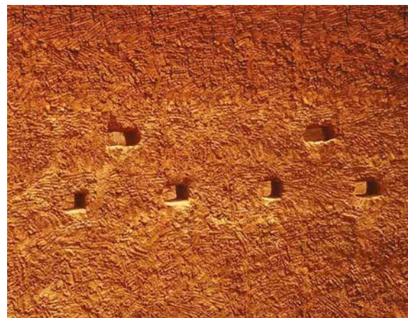
Texture des murs de bauge du centre de ressources de Canchungo
