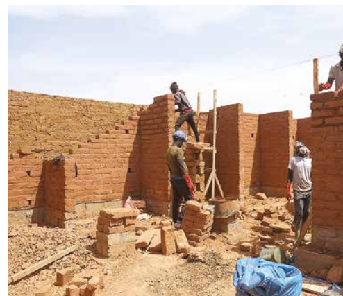
Chantier du premier prototype de grenier amélioré à Matam
