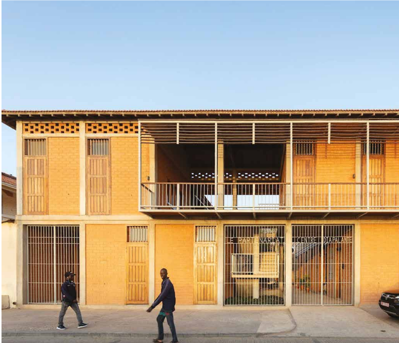
Centre Diapalante, Saint Louis, Sénégal Architectes : Suzanne Hirchi et Laurent Biot Entreprise : #ELEMENTERRE
