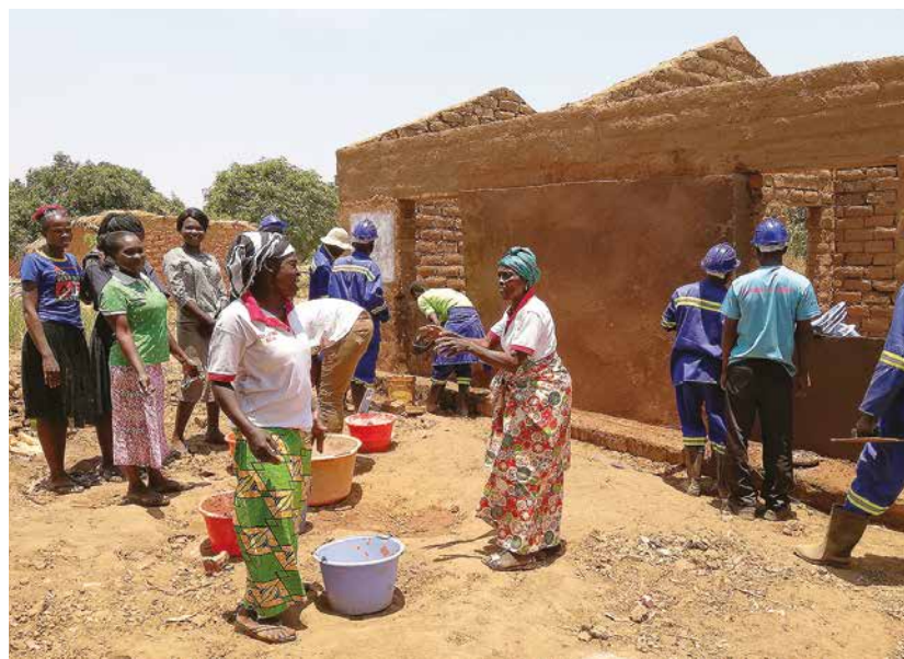
Formation des maçons sur chantier : renforcement de la base du mur par une masse d'usage et traitements de surface des murs extérieurs, basés sur le savoir-faire détenu par les femmes.
