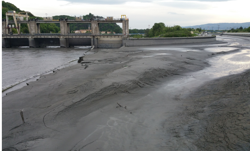
FIGURE 2.10. Dépôts amont au barrage de Beaumont-Monteux en 2015.
