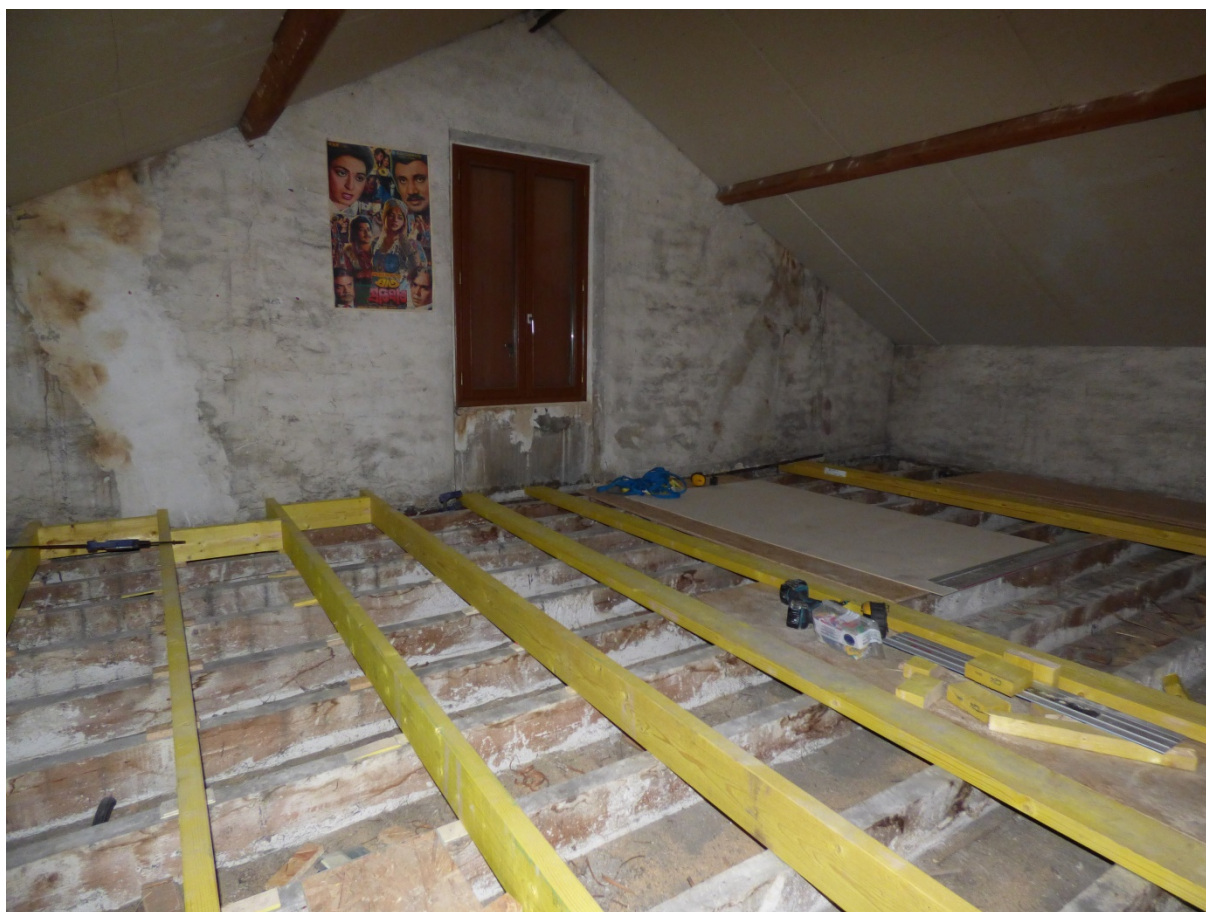
Travaux d'aménagement des combles. Source : un ménage ayant rénové.
