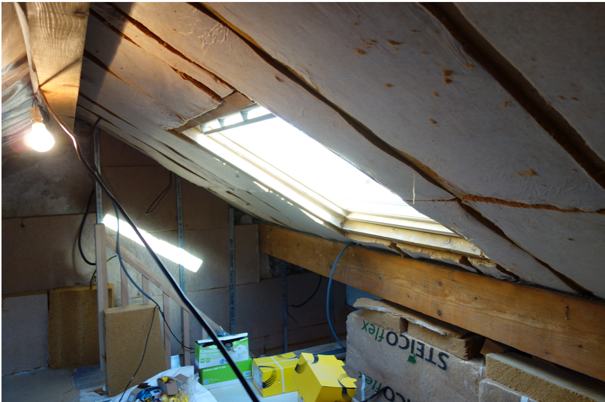
Travaux d'isolation du toit. Source : un ménage ayant rénové.
