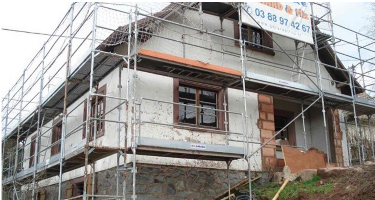
Rénovation avec Oktave https://www.oktave.fr/renovations/maison-de-campagne/
