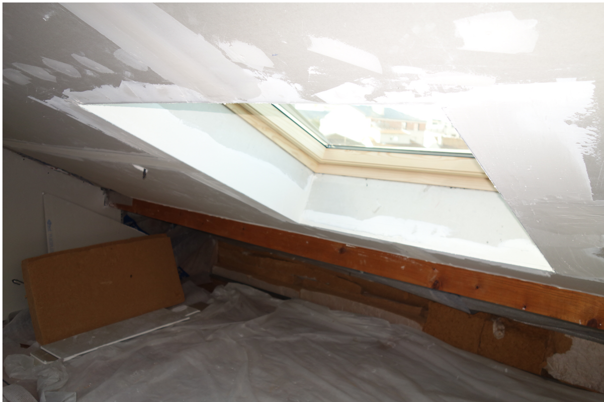
Remplacement des velux. Source : un ménage ayant rénové.
