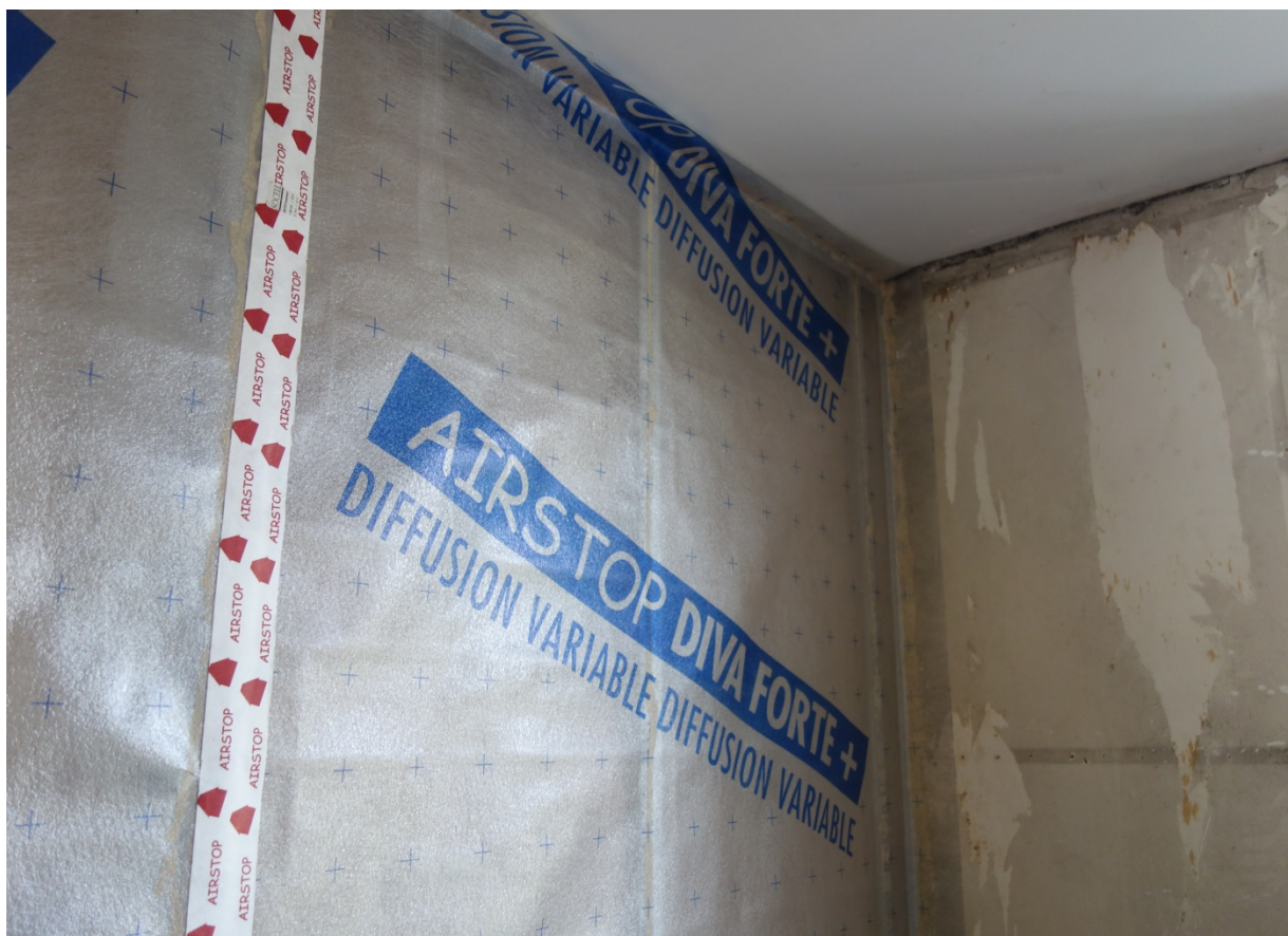
Travaux d'isolation par l'intérieur. Source : ménage ayant rénové
