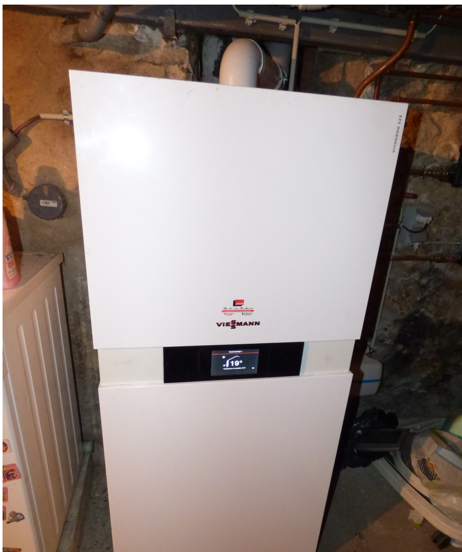
Changement de chaudière à condensation. Source : un ménage ayant rénové.
