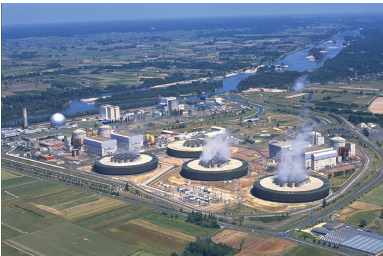
Figure 1 : La centrale de Chinon aujourd'hui. Au fond, proche de la Loire, les réacteurs UNGG en démantèlement, au centre, les réacteurs à eau sous pression en exploitation avec les quatre tours aéroréfrigérantes (source EDF).
