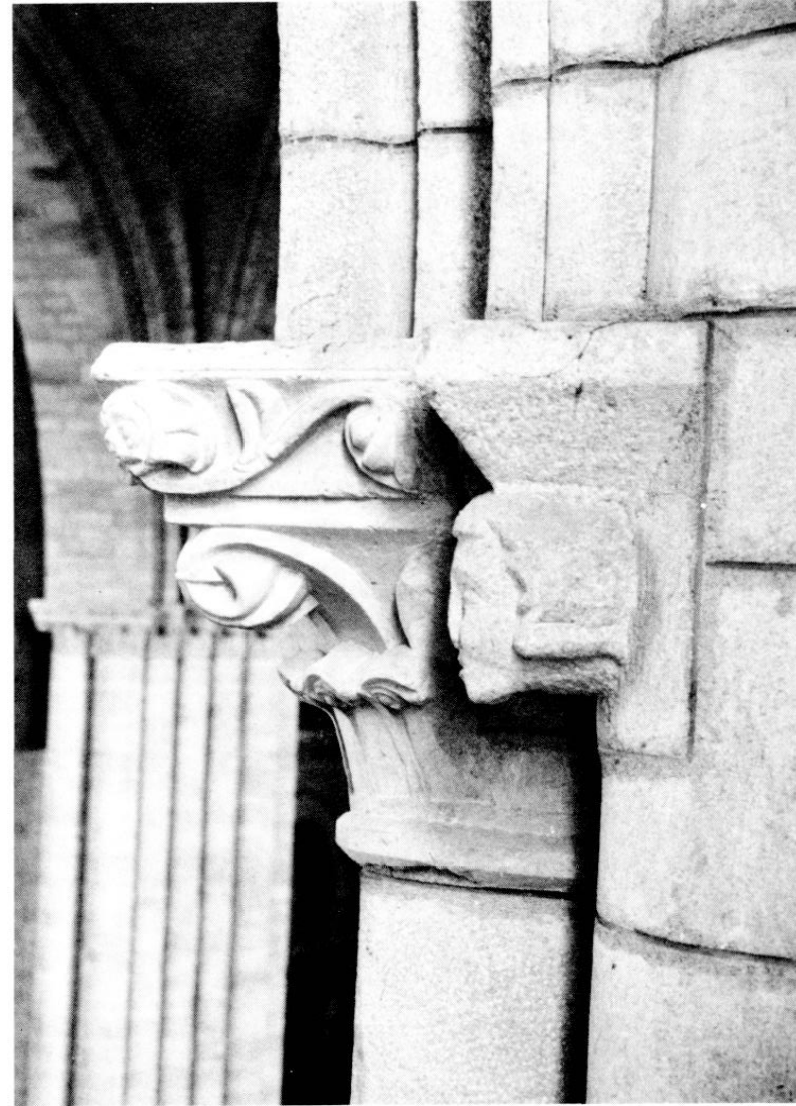
Fig. 14. — Ibid. Pile médiane du gouttereau sud de la nef : chapiteau de la série du chœur et console de granit.
