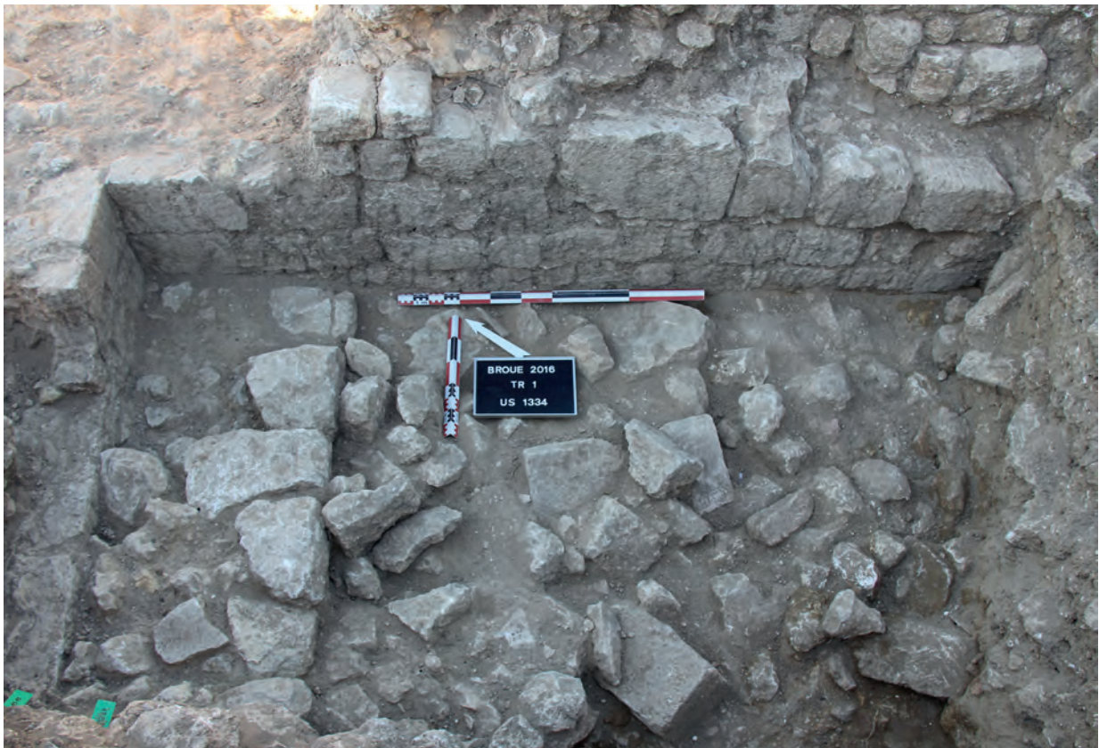
2 : Tranchée 1 - bâtiment 7 - couche de démolition (us 1334)
