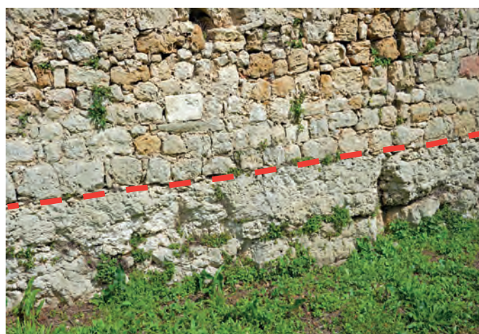
3 : Apparition du substrat rocheux à la base de la chemise de la tour
