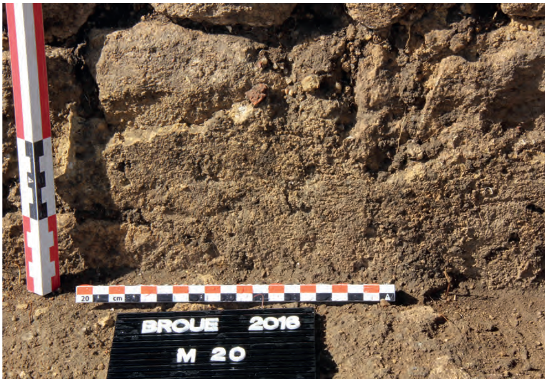
2 : Tranchée 1 - Mur 20 - détail de l'enduit
