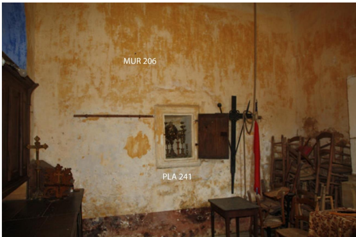
Fig. 68 - Placard aménagé dans le mur nord du premier niveau de la tour-clocher
