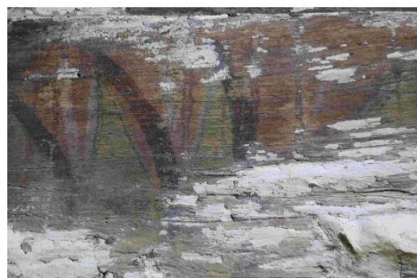
Plafond à la française avec décor polychrome en rez-de-chaussée : détail d'un motif de feuillage
