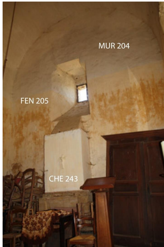
Fig. 67 - Cheminée aménagée contre le mur est de la tour-clocher
