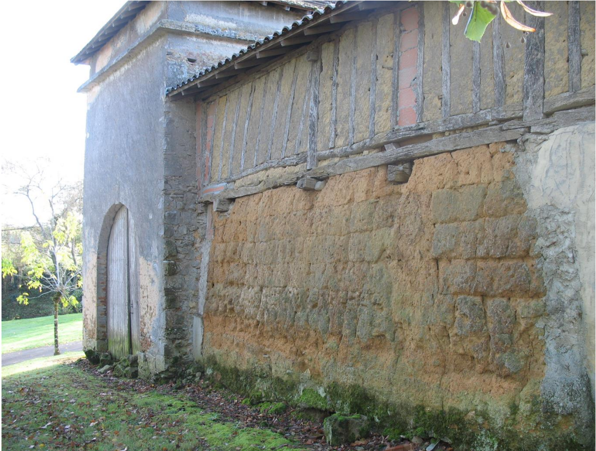
Fig. 13 : Photographie du mur en terre massive et de la porte visibles à l'extrémité nord de plate-forme du Castet, prise depuis le nord (cliché : N. Guinaudeau)
