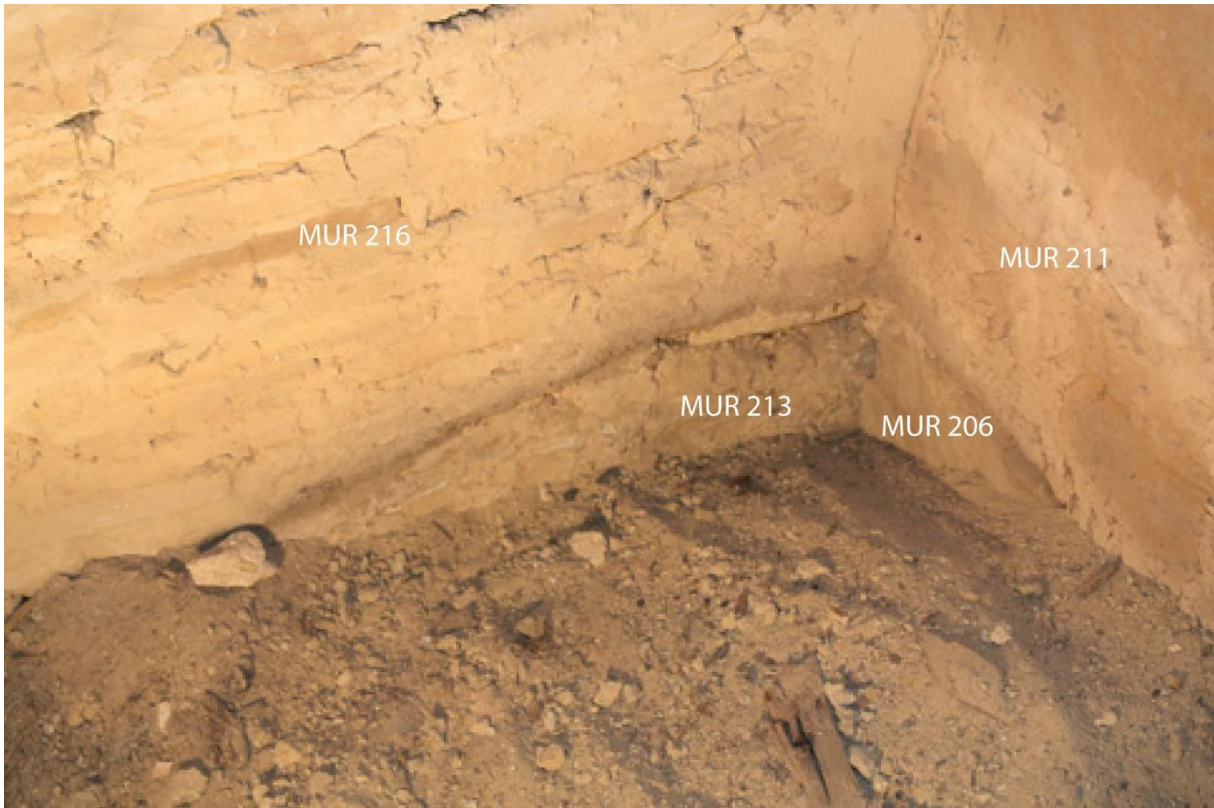
Fig. 31 - Détail de la maçonnerie en petit appareil arasée pour la construction de la surélévation du mur de chevet en maçonnerie de briques
