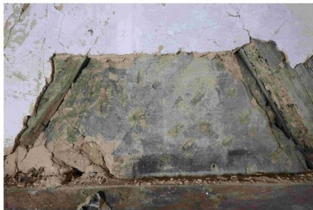
Mur Est, 1 er étage, les fragments de décors rencontrés constituent les rares témoins des premières phases de construction pour cette façade largement remaniée
