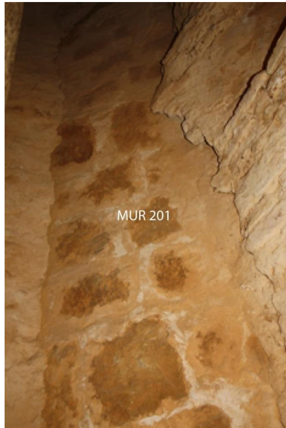
Fig. 69 - Liaison de la partie inférieure de l'escalier en vis contre le parement extérieur du mur sud de la tour-clocher
