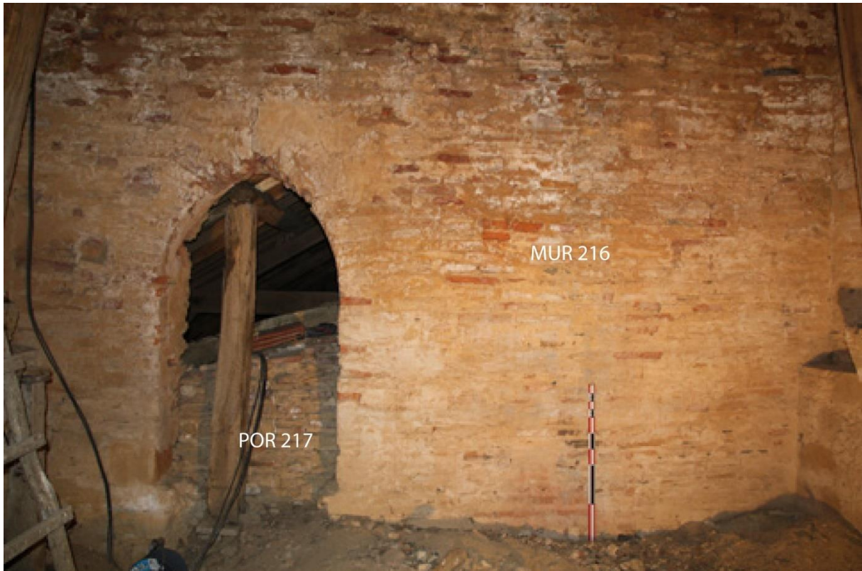
Fig. 32 - Surélévation du mur de chevet en maçonnerie de briques
