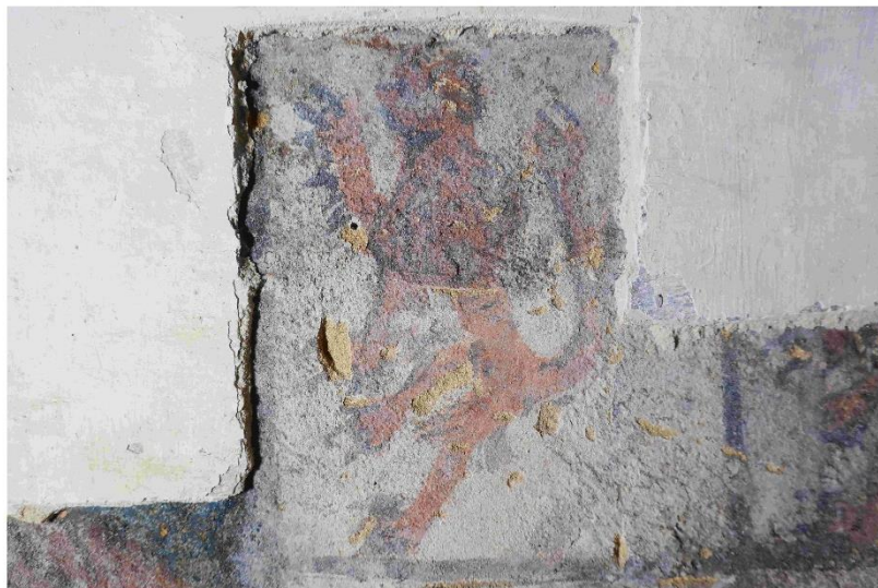
Détail du motif d'armoire. L'affadissement du pigment rouge en partie basse est lié à son exposition à la lumière et à l'air libre depuis son dégagement en 2006. Les dégagements de décors doivent être accompagnés d'intervention de conservation.
