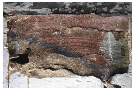
Le décor mural et le plafond sont contemporains : les enduits viennent mourir sur les poutres, les recouvrent parfois et les motifs sont similaires
