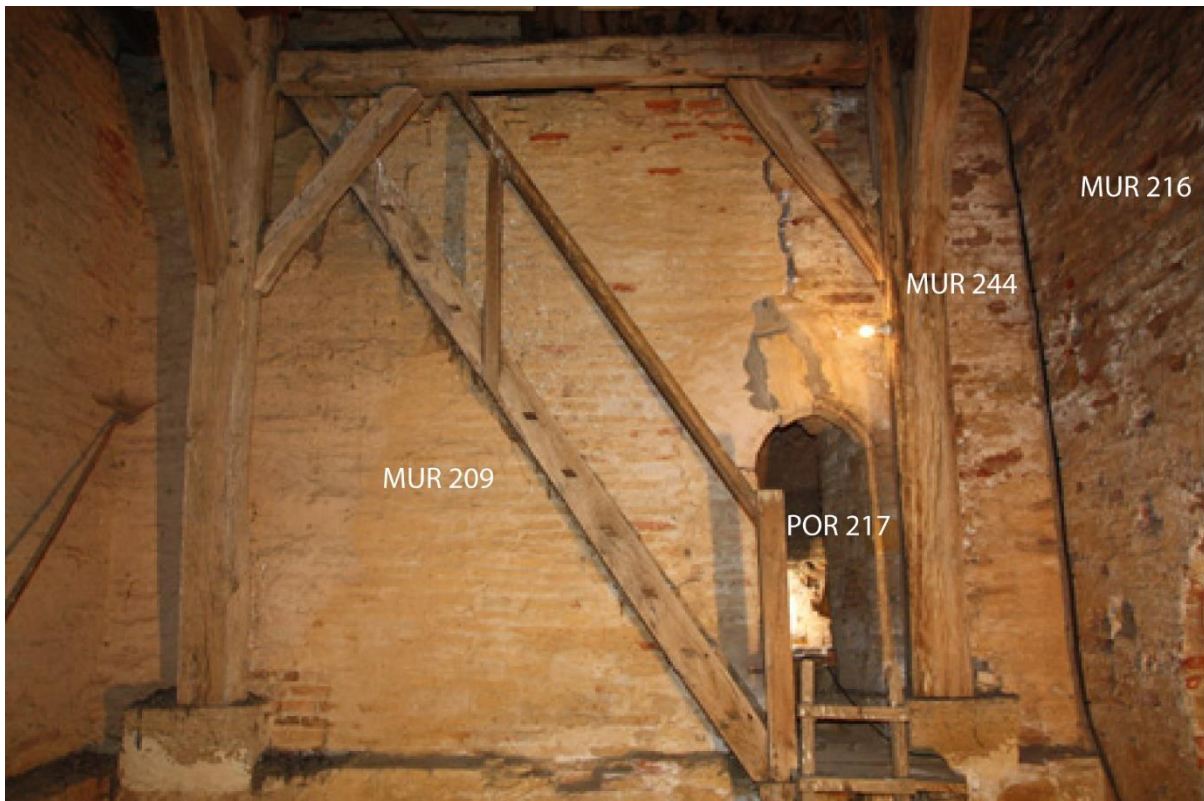
Fig. 61 - Mur sud de la surélévation de la tour-clocher en maçonnerie de briques
