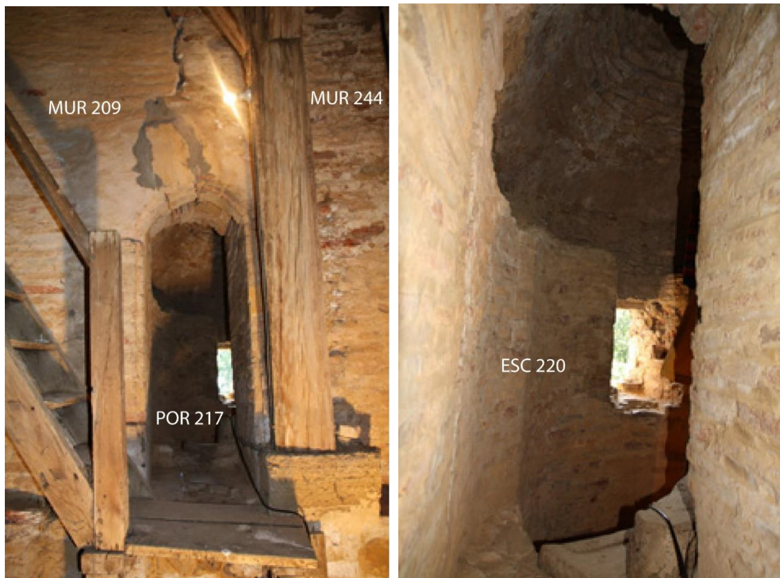
Fig. 63 et Fig. 64 - Porte aménagée dans le mur sud du deuxième niveau de la tour-clocher et vue de la partie supérieure de l'escalier en vis
