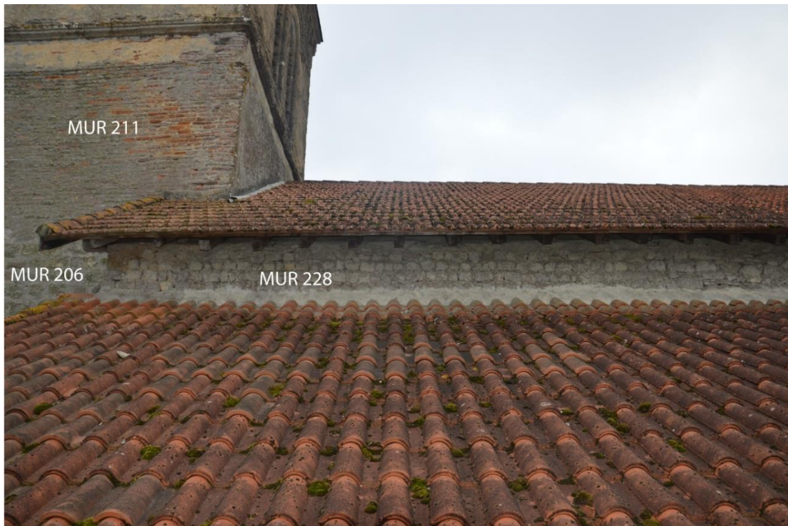
Fig. 24 - Parement extérieur du mur gouttereau nord de l'église Saint-Pierre
