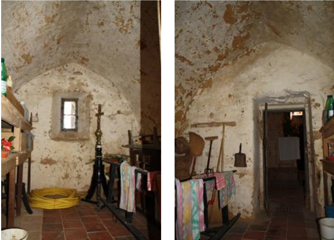
Fig. 44 et Fig. 45 - Salle du deuxième niveau du bâtiment nord
