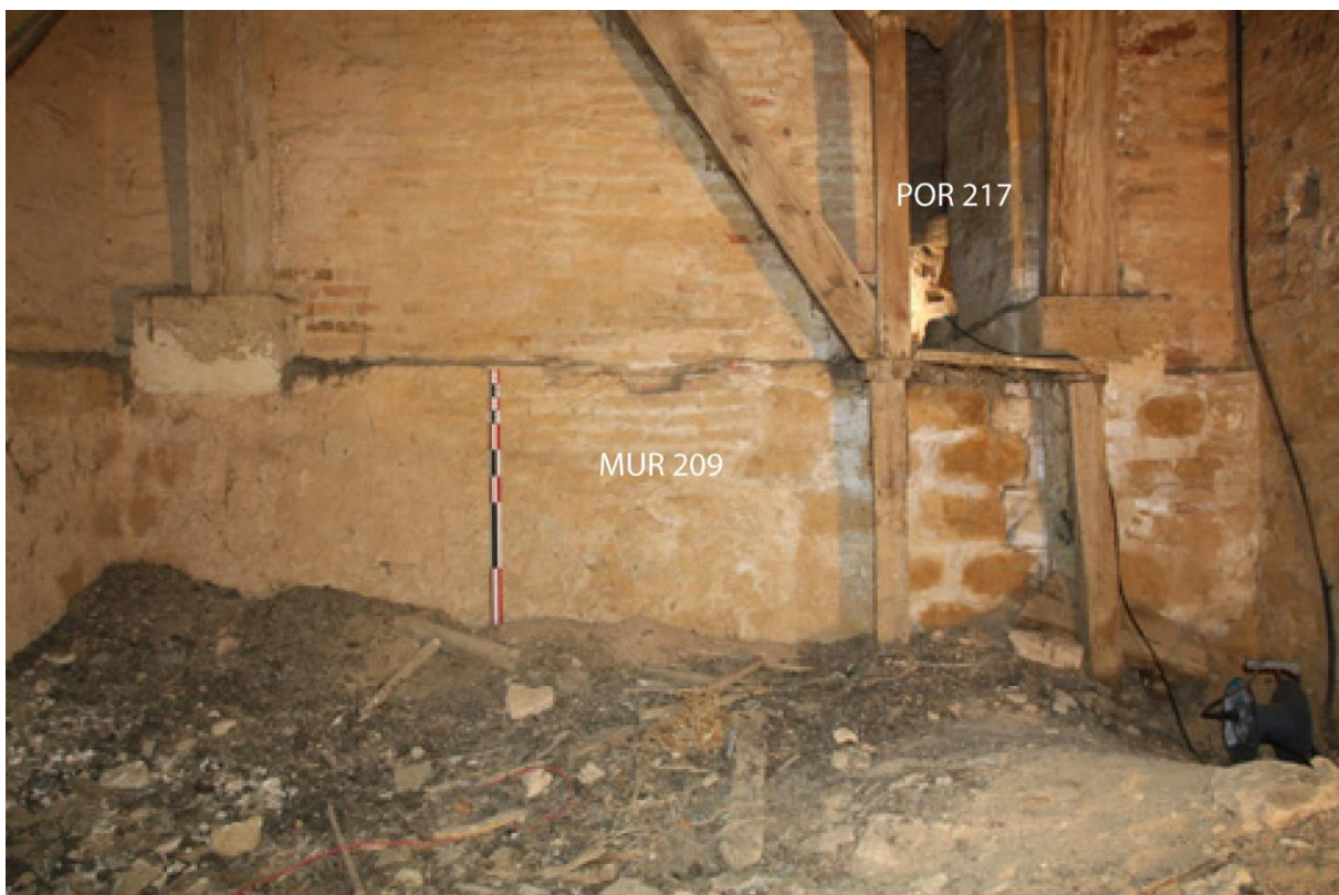
Fig. 62 : Partie inférieure du mur sud du deuxième niveau de la tour-clocher
