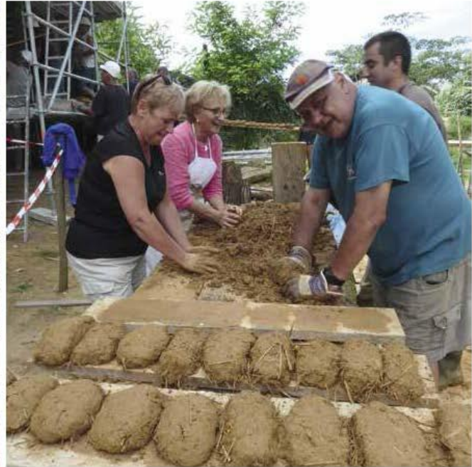
Les habitants ont œuvré à la préfabrication des galettes de torchis.
