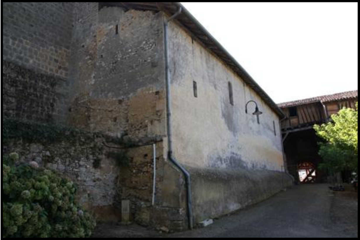
Fig. 43 - Vue du mur gouttereau du collatéral nord de l'église Saint-Pierre
